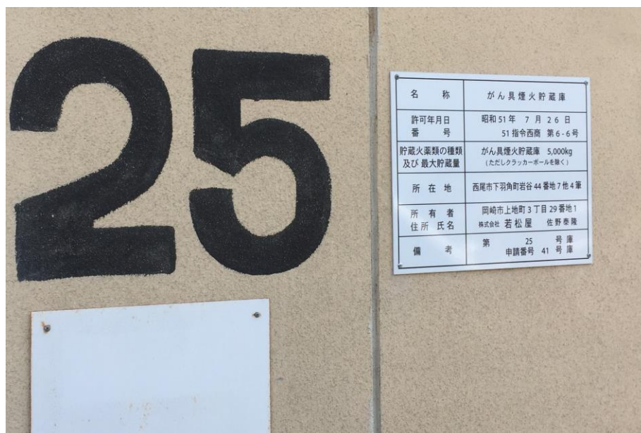
圖 4.10 儲存倉庫外部標示
