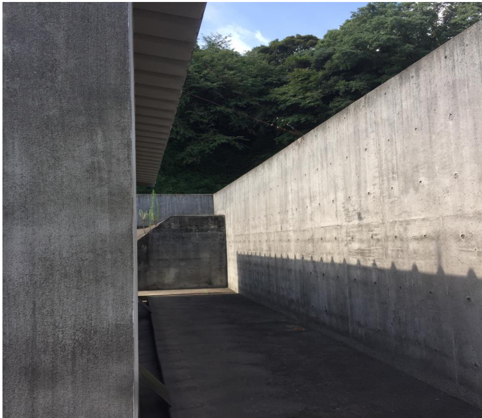
圖 4.13 專業爆竹煙火倉庫外牆與擋牆
