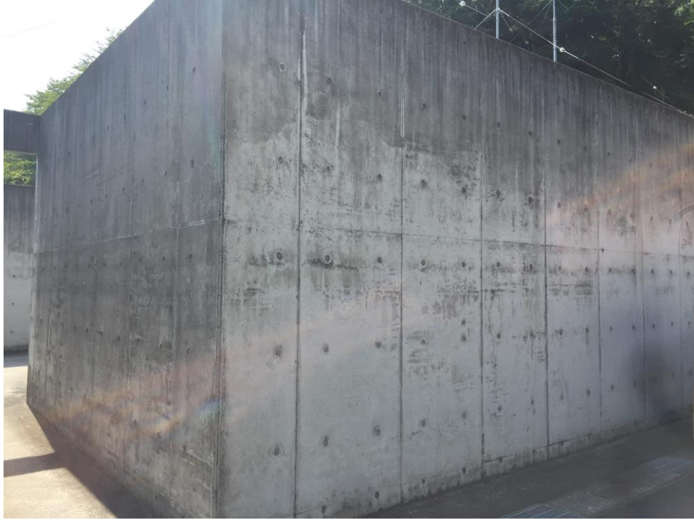
圖 4.12 專業爆竹煙火倉庫擋牆
