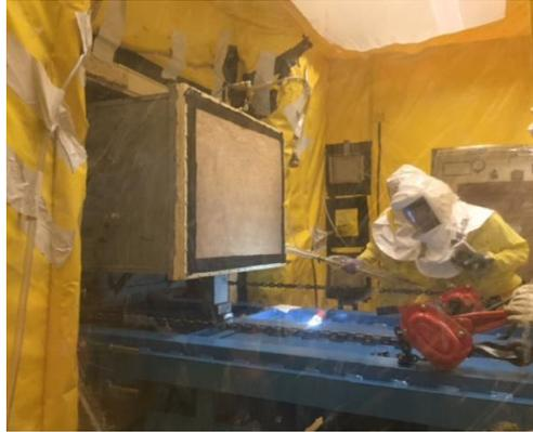
圖 35：HFEF 熱室視窗更換作業中舊視窗玻璃組移除
