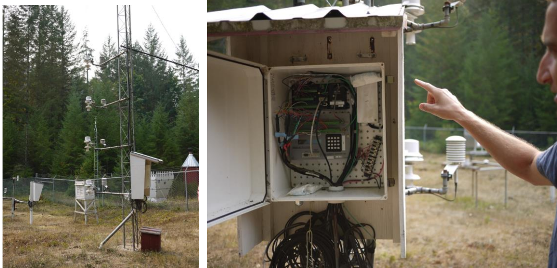
圖 4 主要通訊電塔區的無線傳輸設備。
