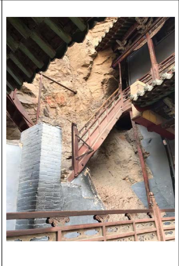
樓梯是順應崖壁面形而設。
