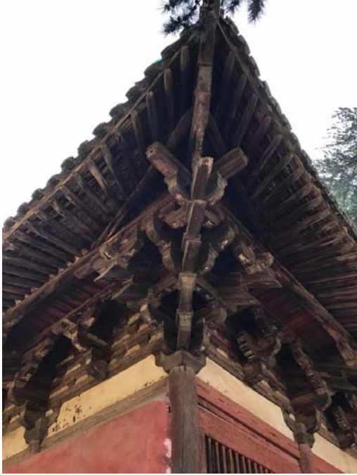
大殿轉角柱上方之斗拱出約 2 米，斗拱精緻。用斗拱、明乳袱、明袱和柱頭枋等將這兩圈柱架緊密聯繫。
