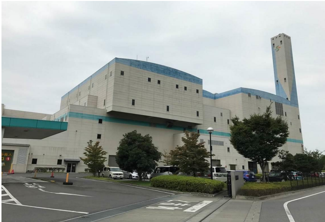
圖 1.1.2 mikamo clean center 垃圾焚燒處理設施
