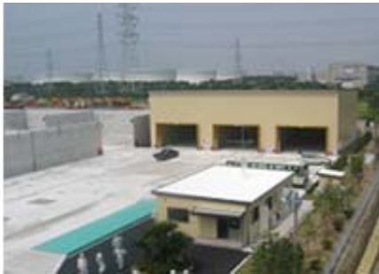
循環資源(株) 袖ヶ浦保管所
