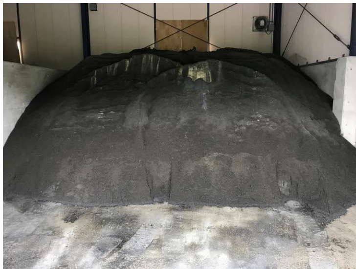
圖 1.1.10 氣化溶融爐之底渣貯存區
