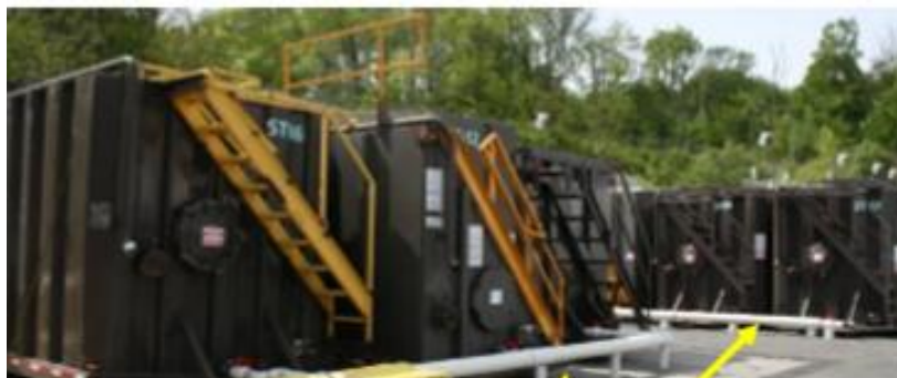
圖 16、加工廠所設置之 Frac tank 臨時儲槽
