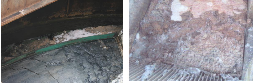
圖 13、畜牧業家禽加工廠的廢水所含的物質堵塞進流口
