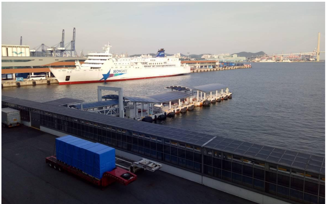
圖 25. 釜山國際郵輪碼頭(內到外)：卡車處為補給作業區、往旅運中心之旅客通道、小型船舶停靠的凸堤碼頭、外圍是大型郵輪的停泊碼頭。
