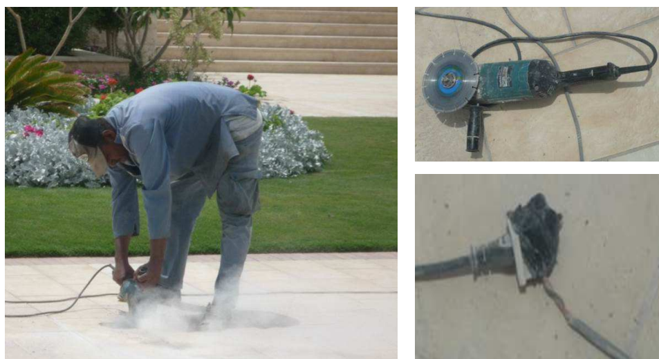
圖 9 工人使用圓盤切割機進行地面裁切施作圖
