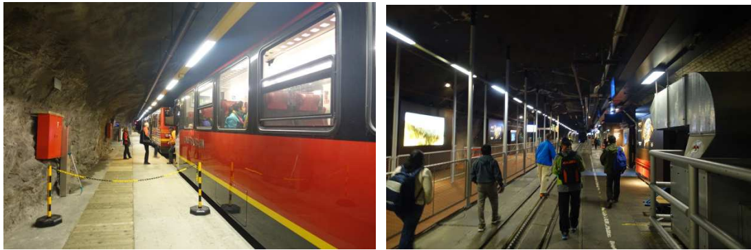
山頂風雪影響，直接將車站設於隧道內，是一個較安全的做法
