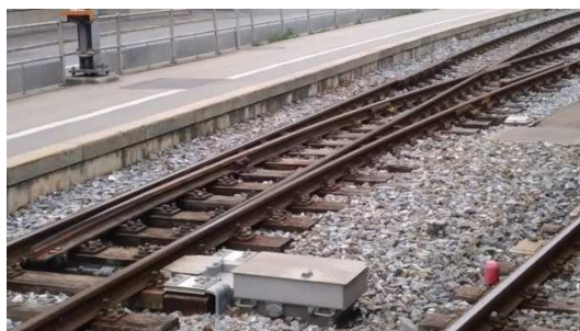
站區內同林鐵採木枕，僅有扣件採蝶型彈性扣件與電動轉轍器
