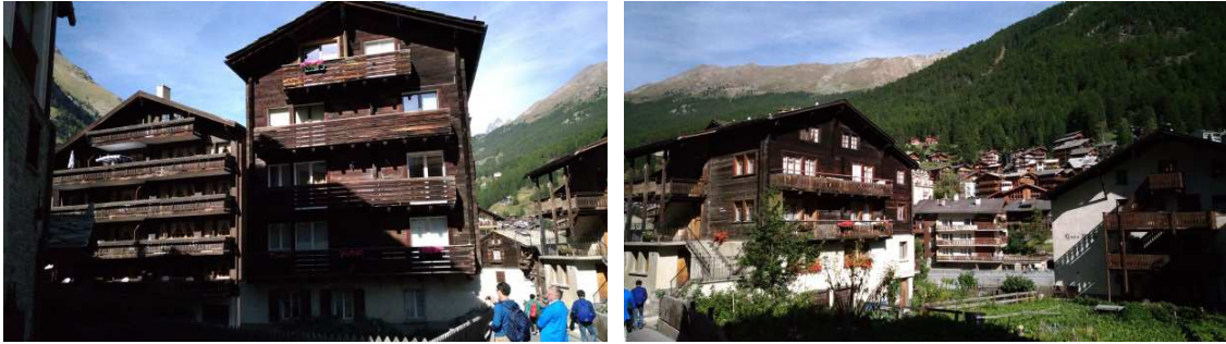
在 Zermatt 到處可見保存完整瓦萊州(Canton of Wallis)的特色建築
