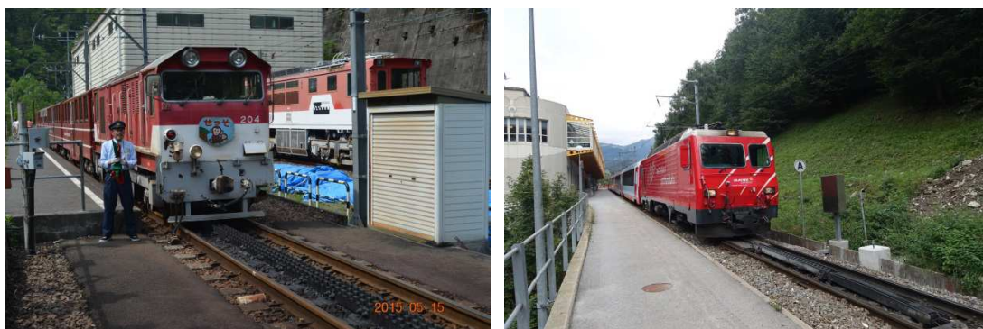
大井川鐵路齒軌使用水泥枕
