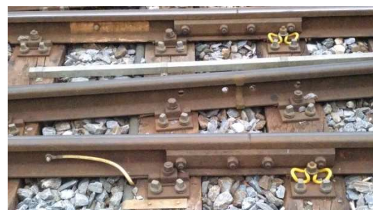
站區內同林鐵採木枕，僅有扣件採蝶型彈性扣件與電動轉轍器
