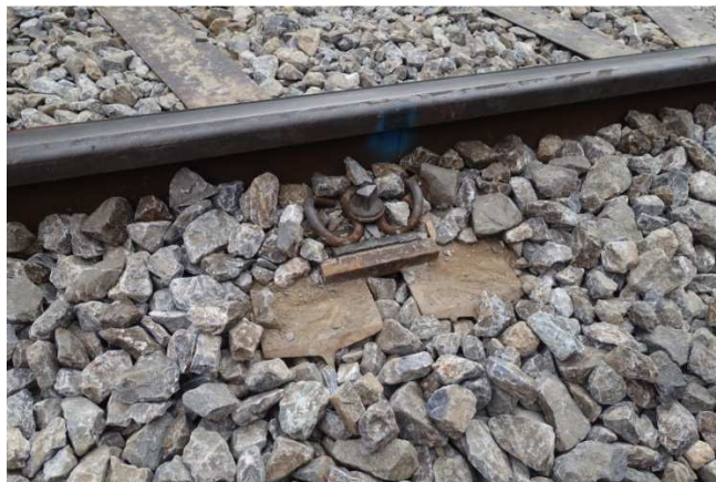
MGB 鐵路所使用的鋼枕及其扣件
