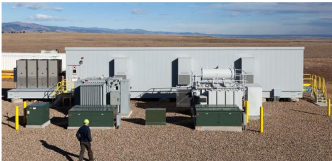
圖 26、7-MVA 可控制電網界面
