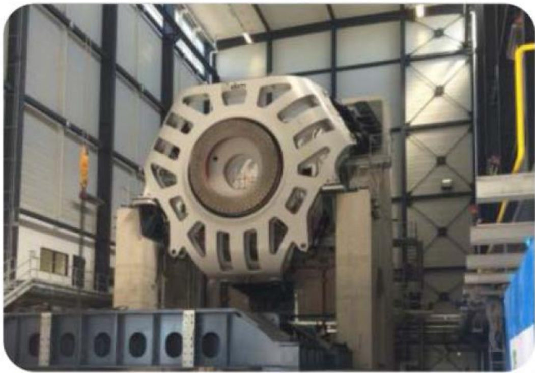
圖 21 IWES Nacelle測試場設備安裝(IWES資料圖片)
