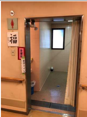
↑ 沒有門檻且有排水溝處理積水
