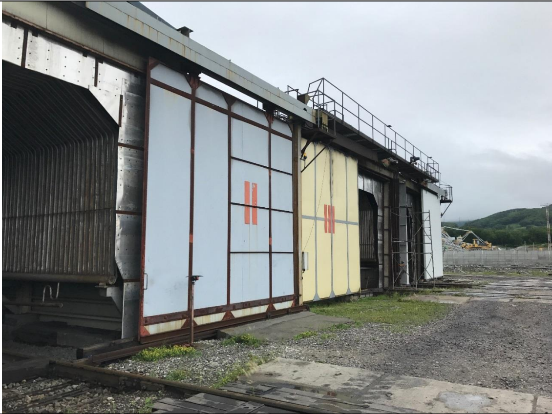
圖34：煤炭加熱設備外觀 (有可關閉之活動門以阻隔風雪)
