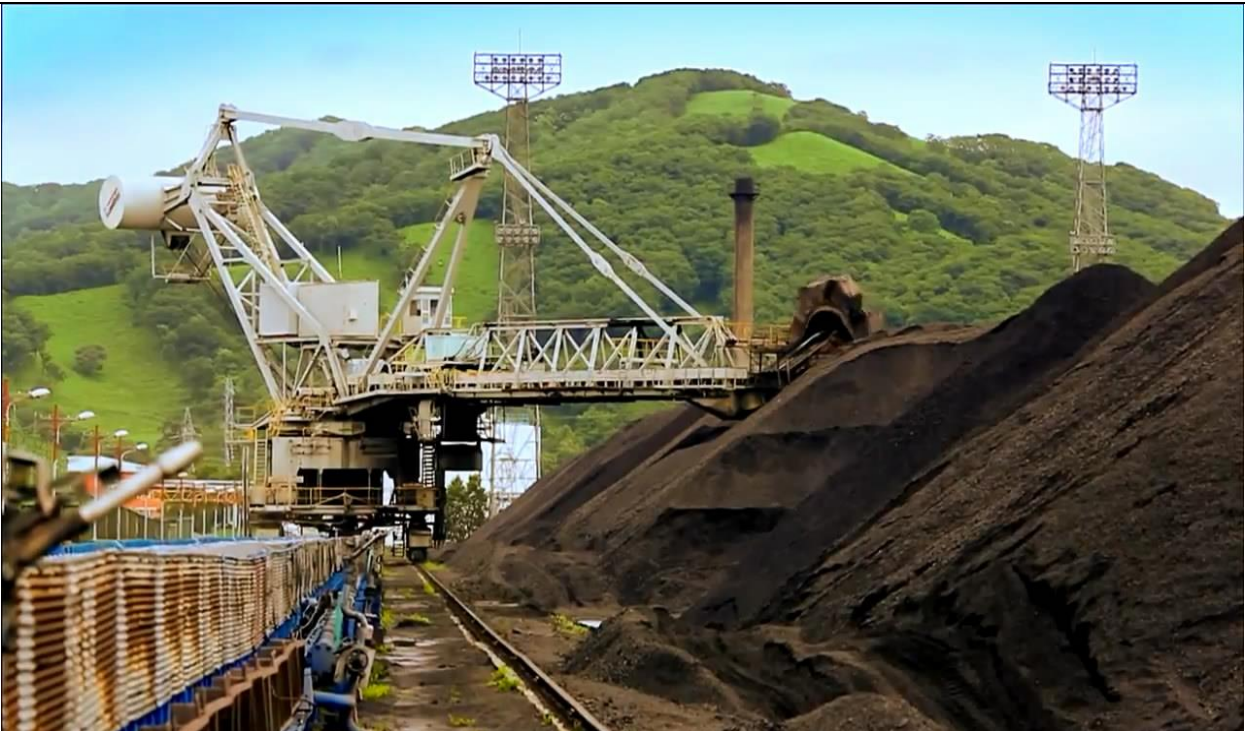
圖41：儲煤場取煤機 (共有4部，處理能力：3,500公噸/小時/部)
