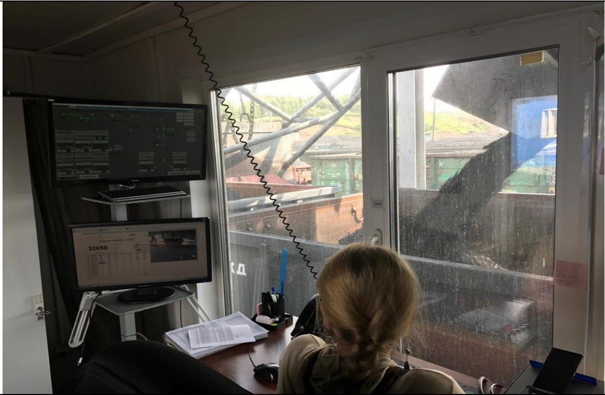
圖24：鐵路裝煤設備控制室 (左側螢幕可監控裝煤設備運作情形及敞車裝載量)
