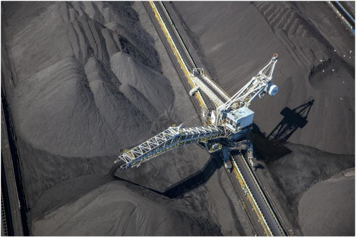
圖40：儲煤場堆煤機 (共有2部，處理能力：3,400公噸/小時/部)
