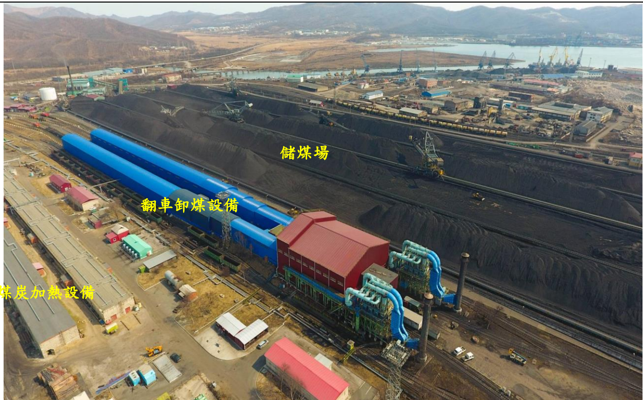
圖33：儲煤場、翻車卸煤及煤炭加熱設備
