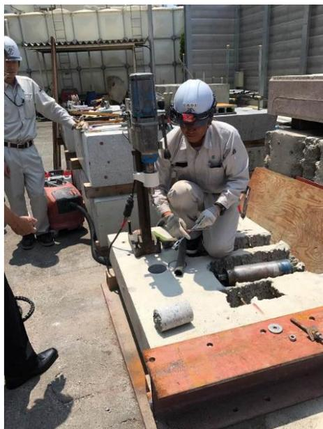
圖 27 鑽孔後取出之水泥圓柱示意圖
