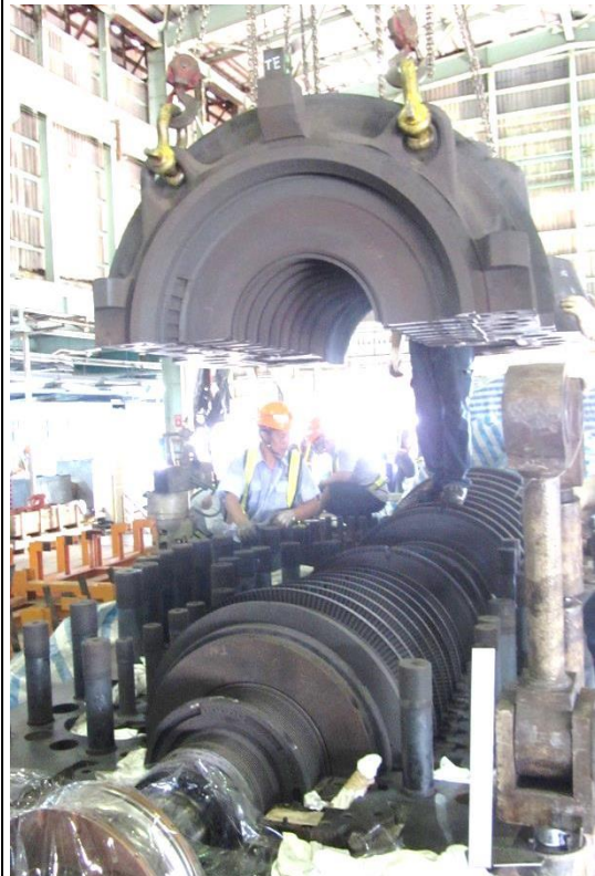
高壓內缸拆解吊掛
