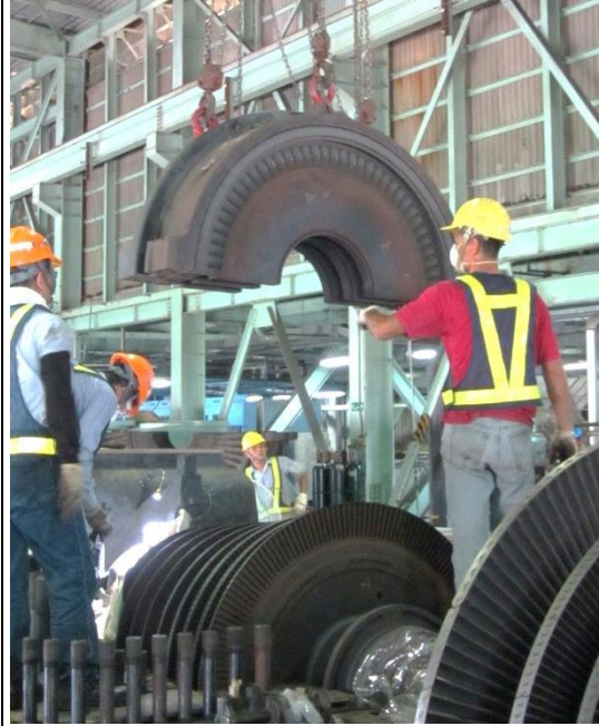
高壓內缸拆解吊掛
