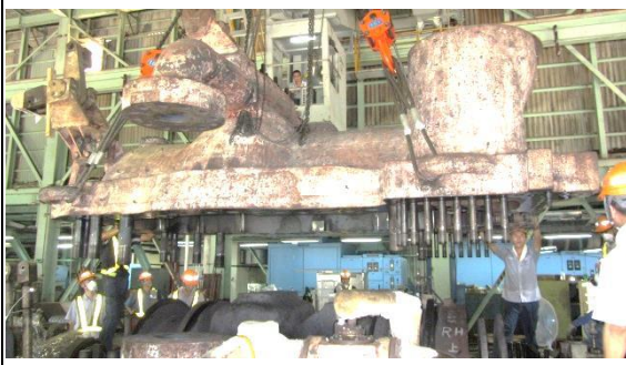
高壓螺栓回裝熱鎖
