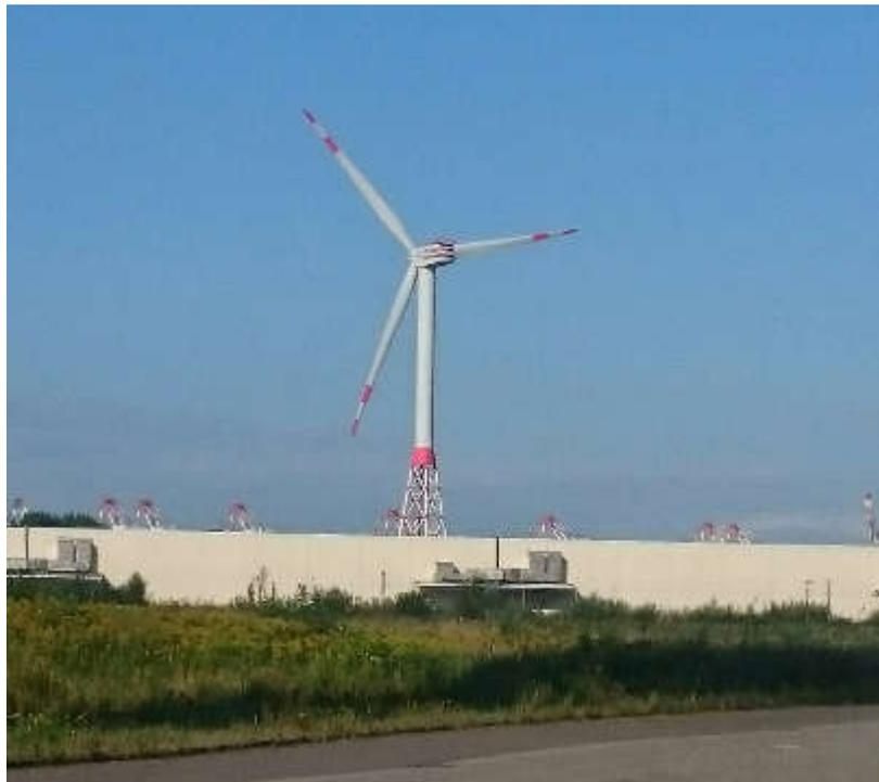
圖 27 採用套管式基底的離岸風力機
