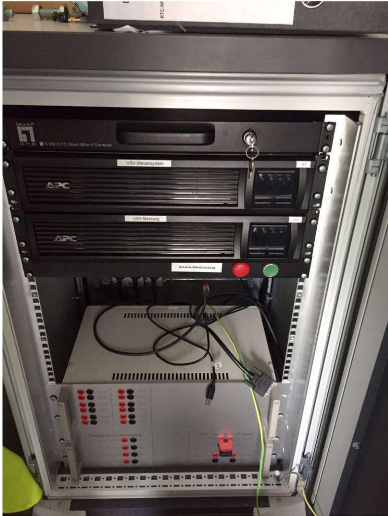
圖 10 不斷電系統供應 LVRT 測試儀器使用
