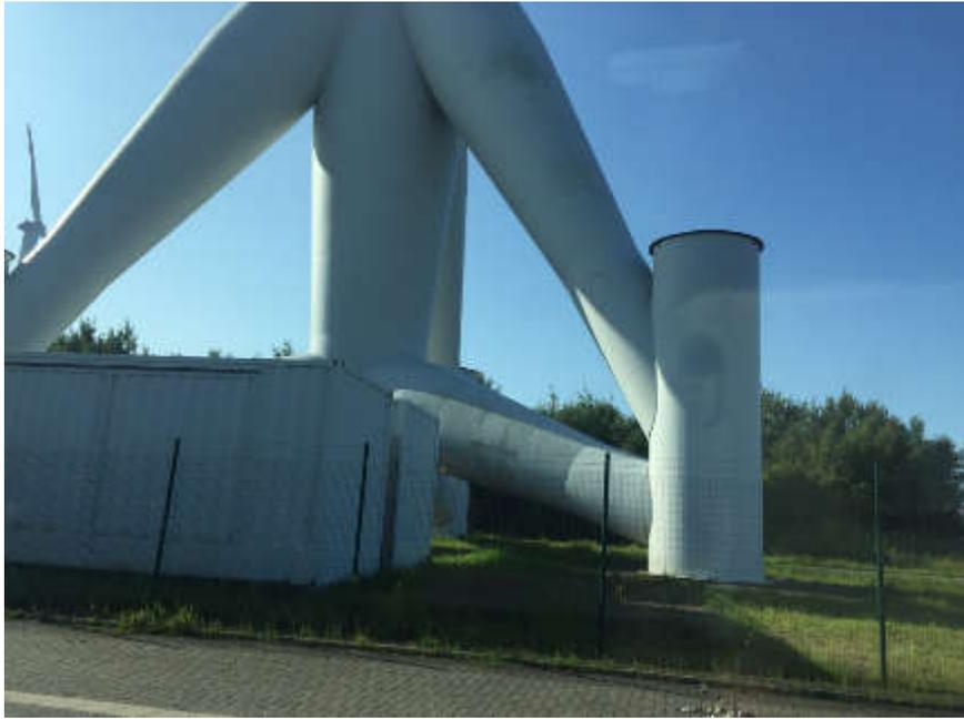
圖 26 採用三腳架基底的離岸風力機
