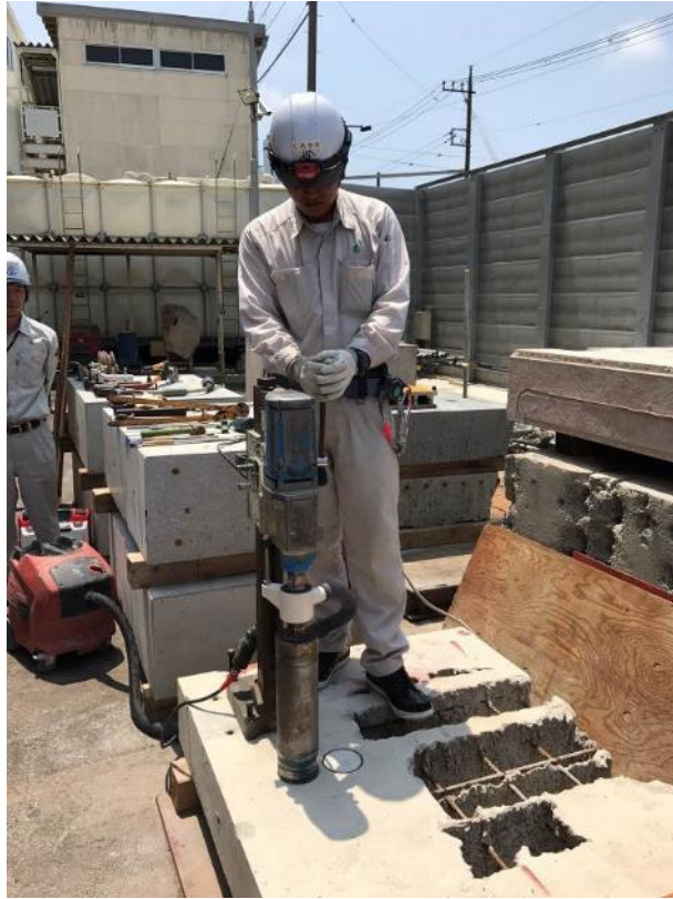
圖 65 鋼筋混凝土塊之乾式鑽孔取樣過程
