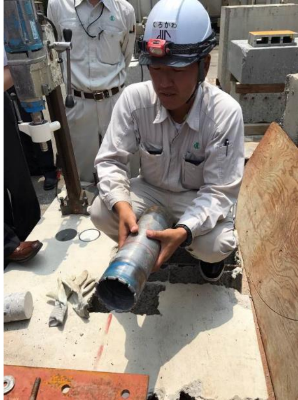
圖 67 鑽孔後拆卸下之鑽孔器具示意圖
