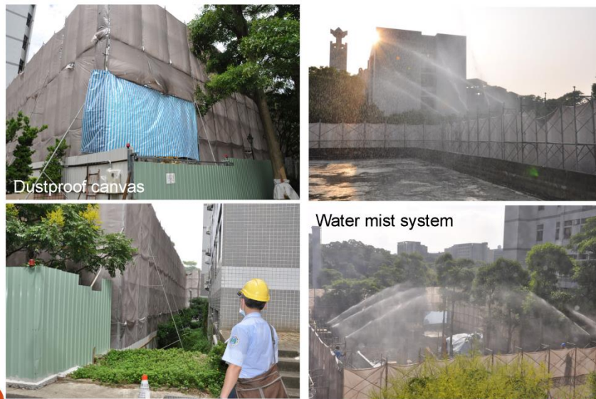
圖 52 拆除作業期間的粉塵抑低措施
