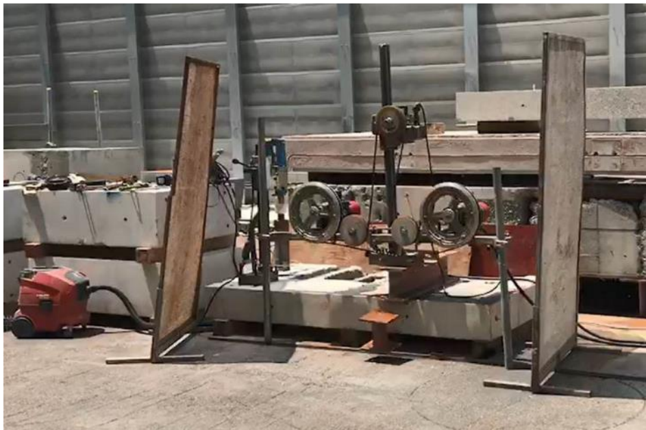
圖 63 鑽石索鋸進行金屬之乾式切割過程(切斷掉落瞬間)
