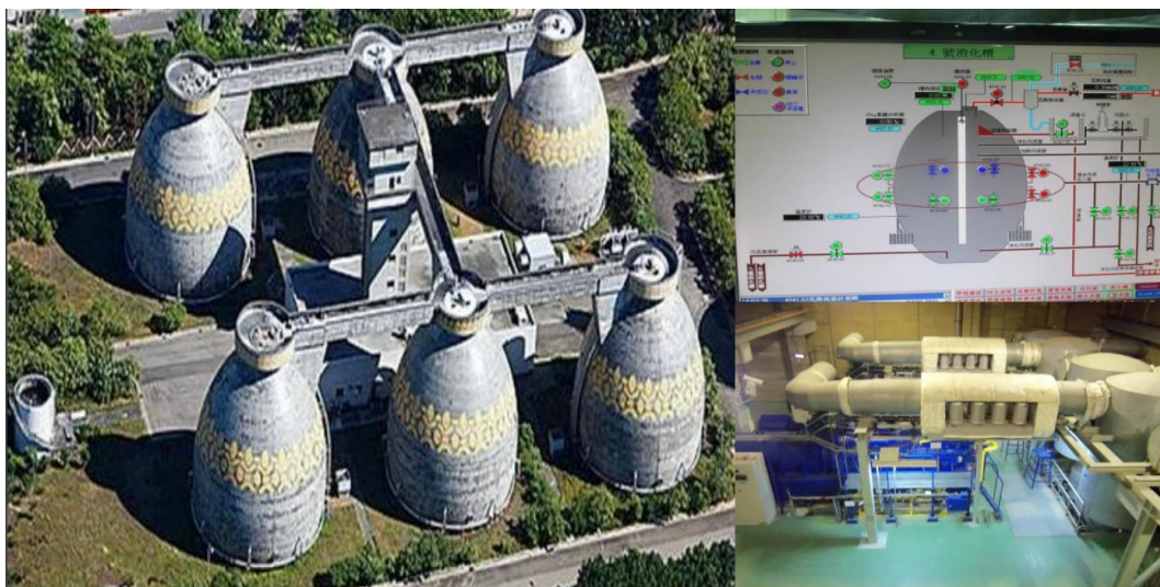
圖 26、八里污水處理廠蛋形消化槽
