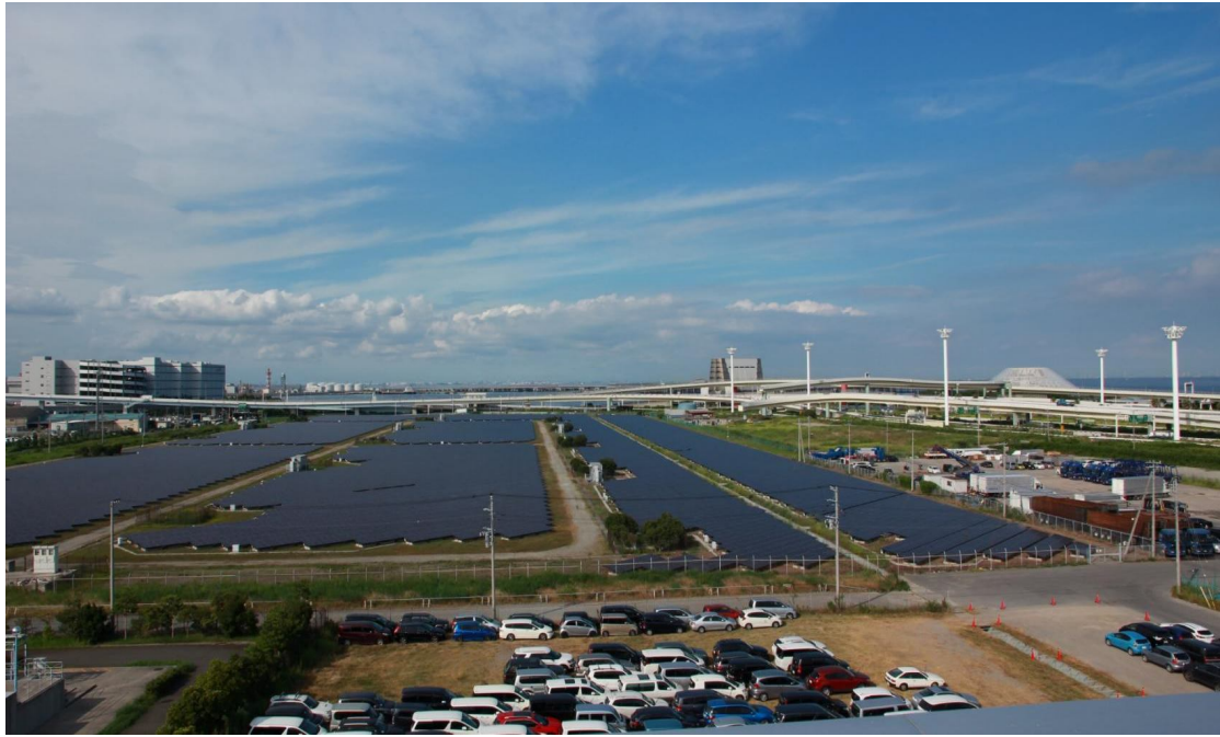
圖 31、浮島太陽光發電所
