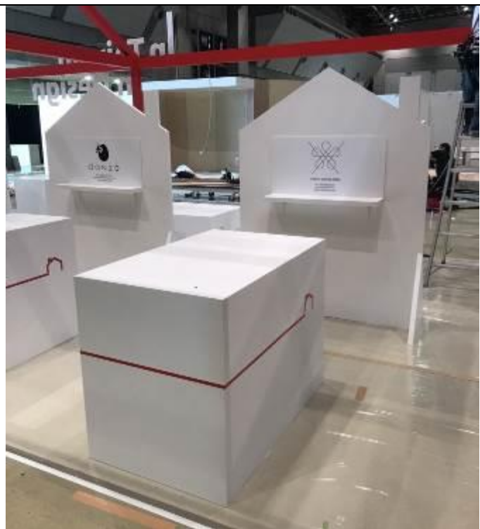
委辦廠商進行展場施工 3
