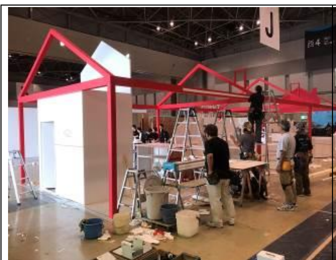
現場施工狀況 1
