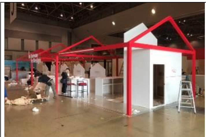
委辦廠商進行展場施工 1
