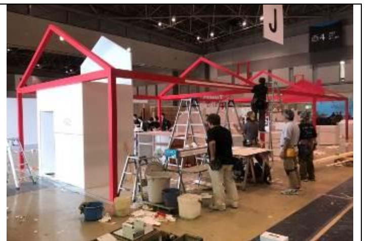
委辦廠商進行展場施工 2
