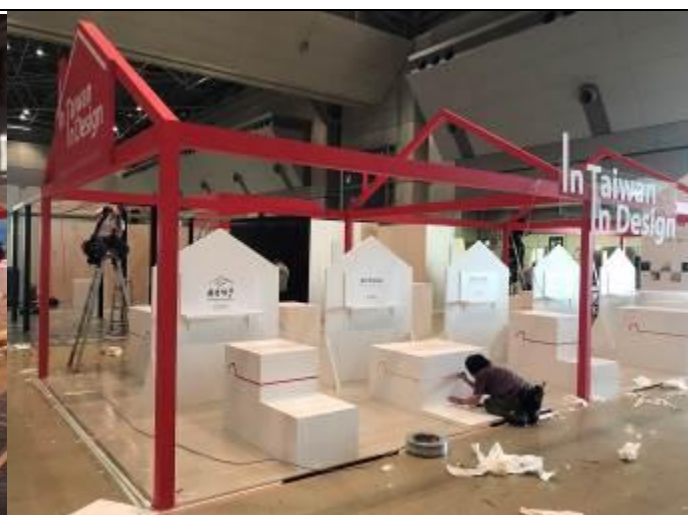
現場施工狀況 2
