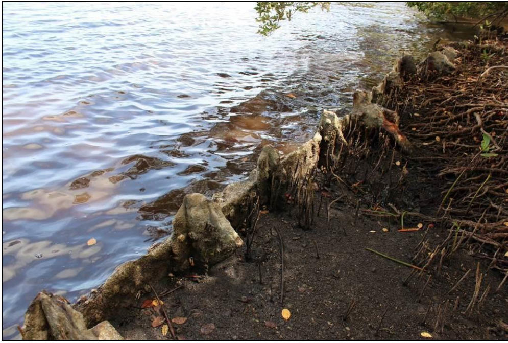
圖 3-20 JOBOY bay 岸邊的紅樹林與鋼板護岸
