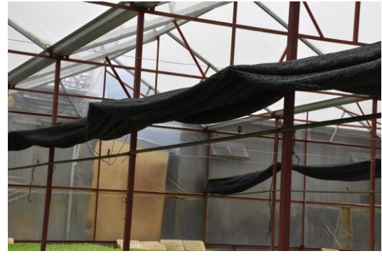
以鐵材為材料搭建的栽培設施
