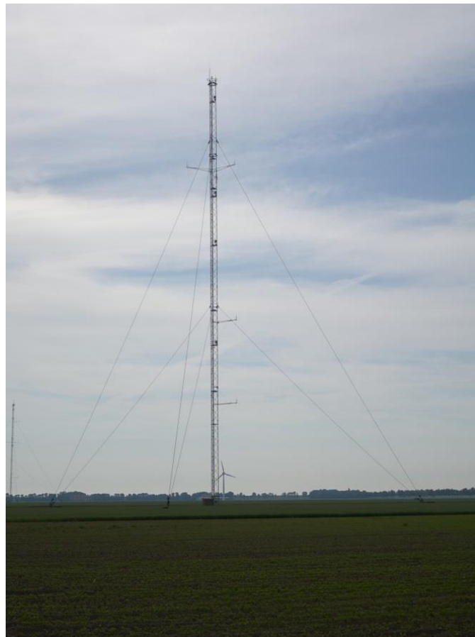
圖 15、陸域氣象觀測塔 1 號(高度：108 m)
