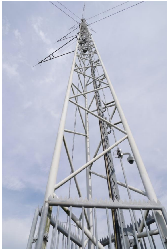
圖 16、安裝儀器之延伸桿
