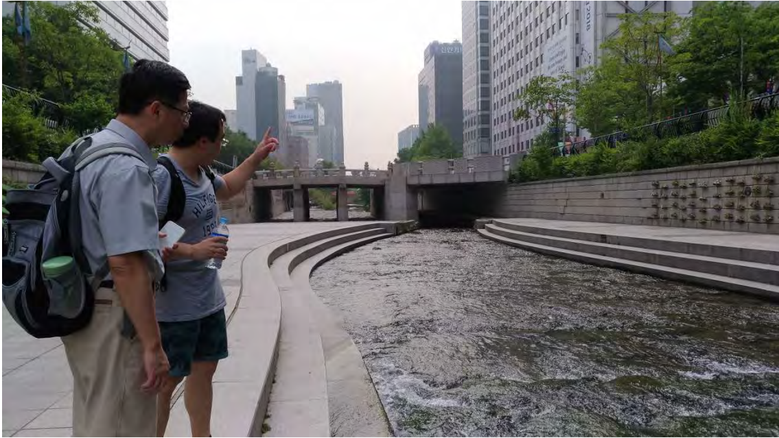
圖 13 為避免河道泥沙淤積於橋底，清溪川河道設計經過橋樑時均會縮減增加水體流速，減少淤泥清理成本
