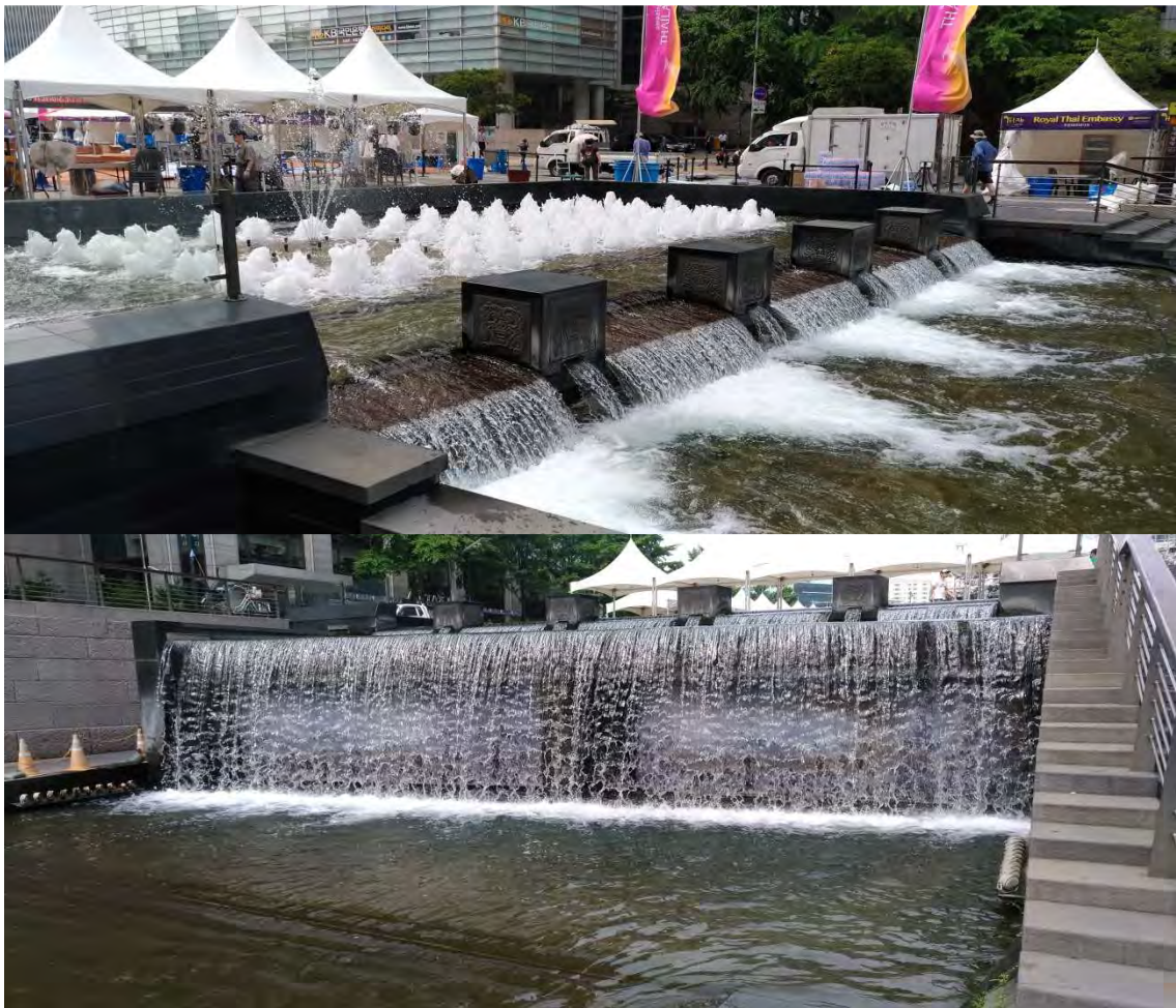
圖 12 清溪川加蓋河段終點進入開蓋段，為避免水體溶氧不足產生異味，以噴泉及瀑布方式曝氣
