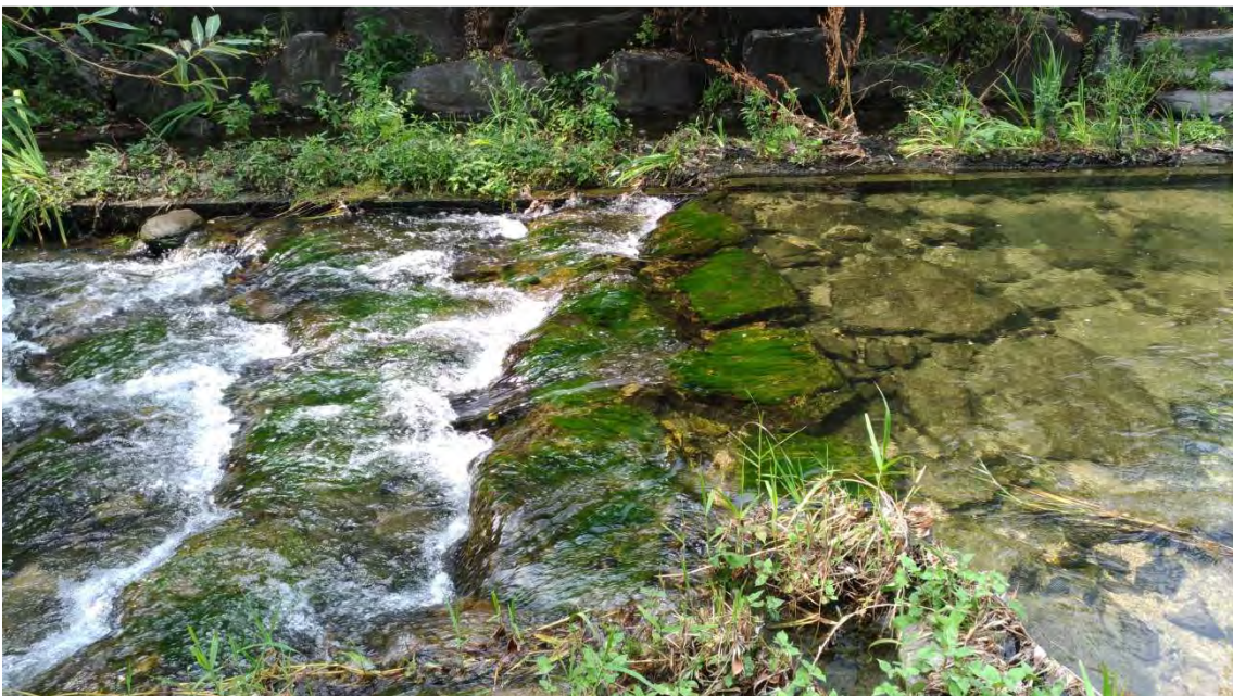
圖 14 運用生態壩創造好氧及厭氧環境，促進生物膜之硝化菌及脫硝菌生長，藉以去除氨氮
