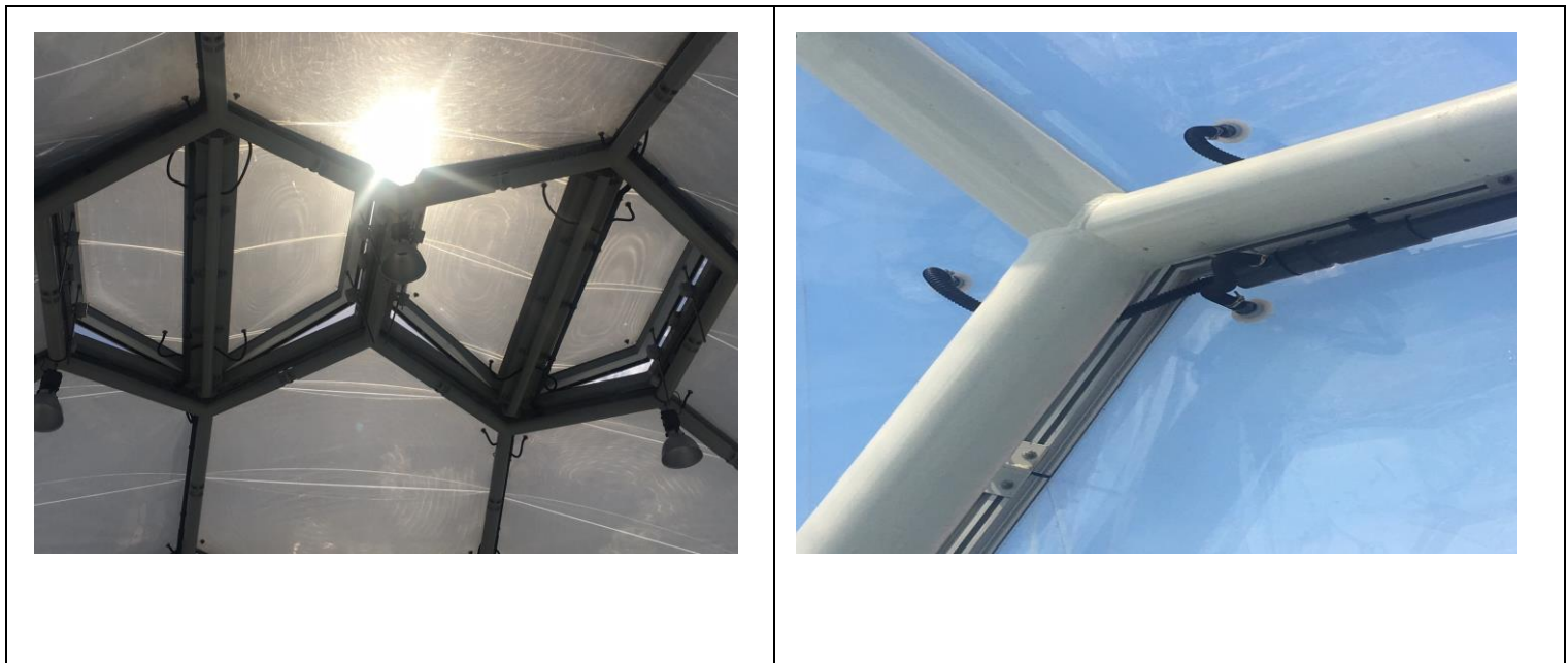
圖 10: ETFE 隔層間有黑色管道調節
