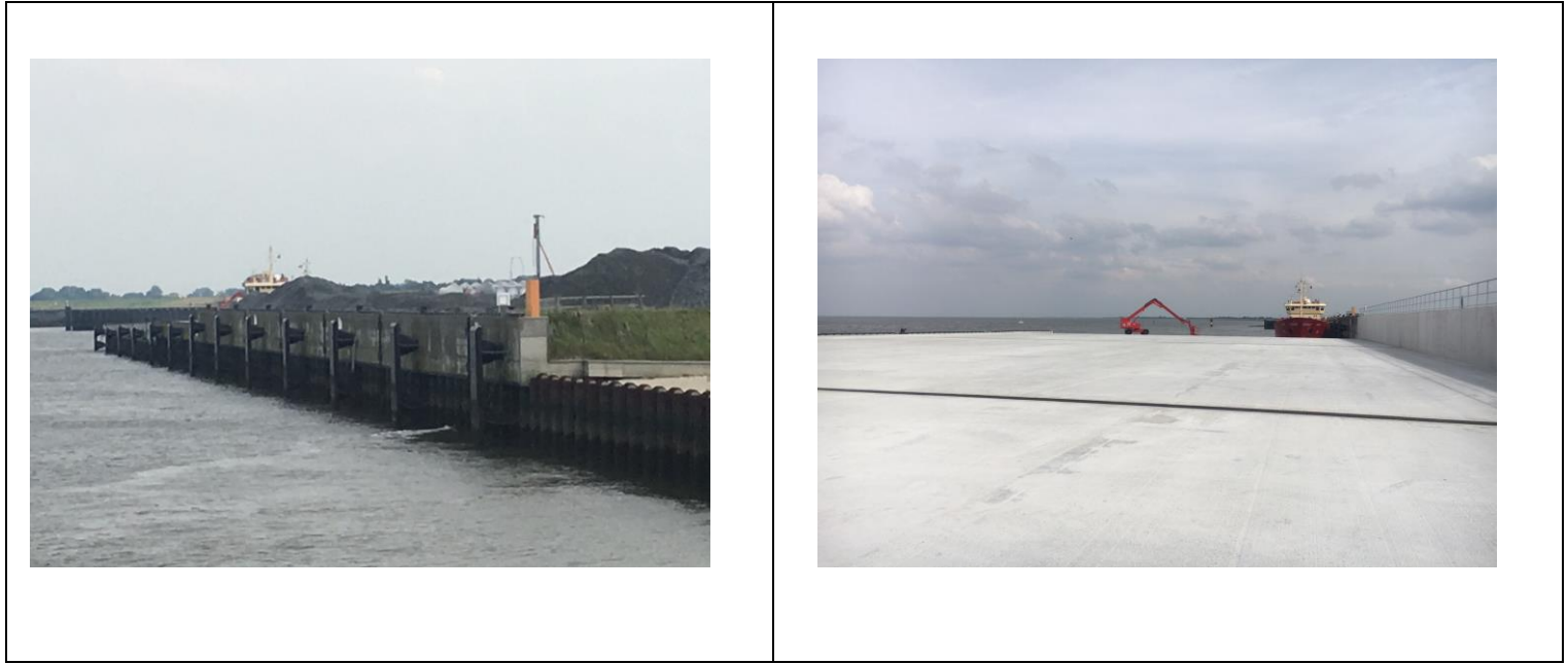
圖 8:LP9.3 碼頭 1.15%的微傾斜設計
