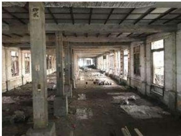
內部整修情形木骨磚造的結構
