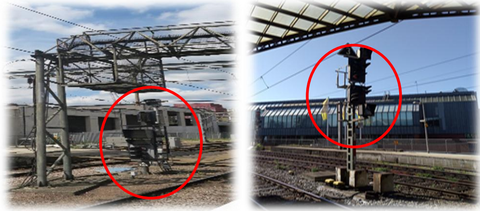
圖 35 號誌機遮罩非只設置於上方，可避免不同股道誤判。
