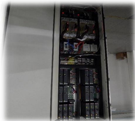
圖 43 無線閉塞中心(Radio Block Center-RBC)機房
