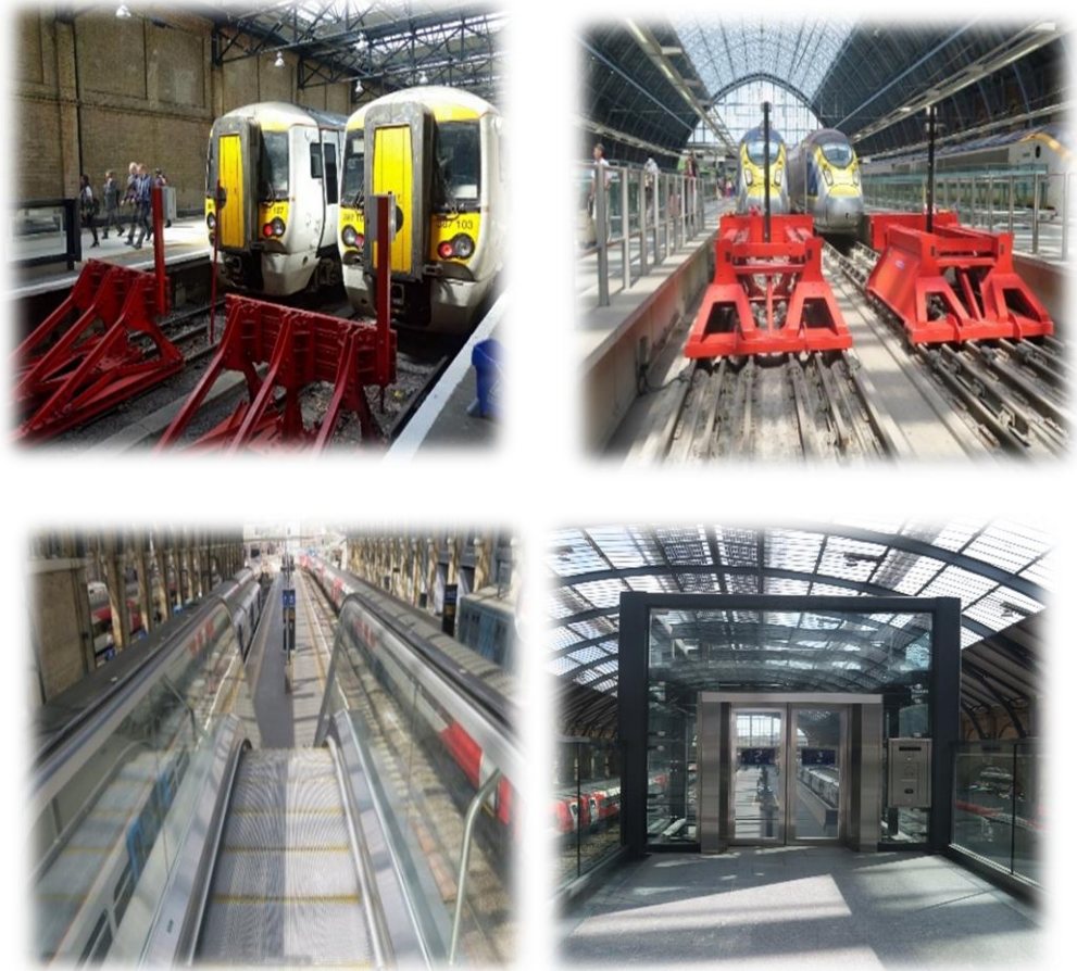
圖 32 月台天橋電扶梯上下起訖之腳踏板及升降電梯
