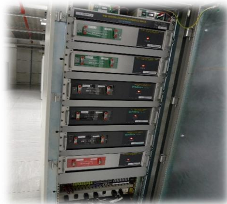
圖 43 無線閉塞中心(Radio Block Center-RBC)機房
