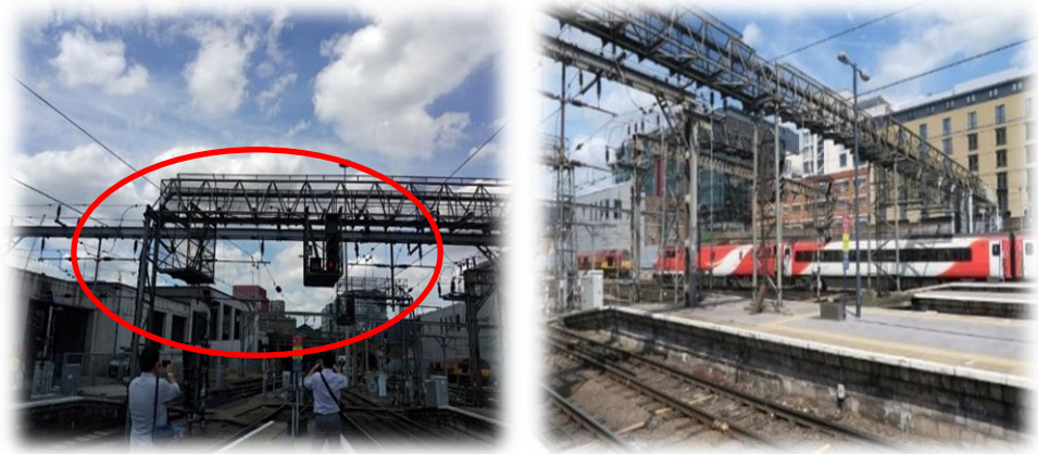
圖 29 號誌機懸掛於軌道正上方或與門型架共構
