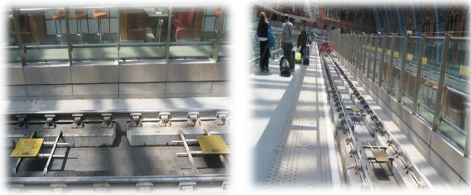
圖 17 列車停車位置裝有 ATS 地上感應裝置(防護衝撞)
