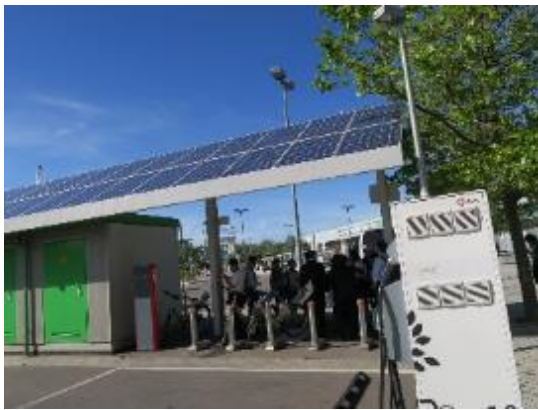
圖 4-43 南十字車站附件的太陽能設備、電動自行車與電動巴士站
