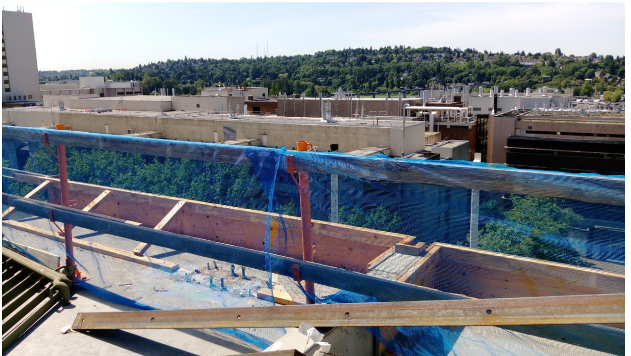
圖 5 大樓頂樓四周開口部分均使用臨時護欄圍住以避免人員墜落
