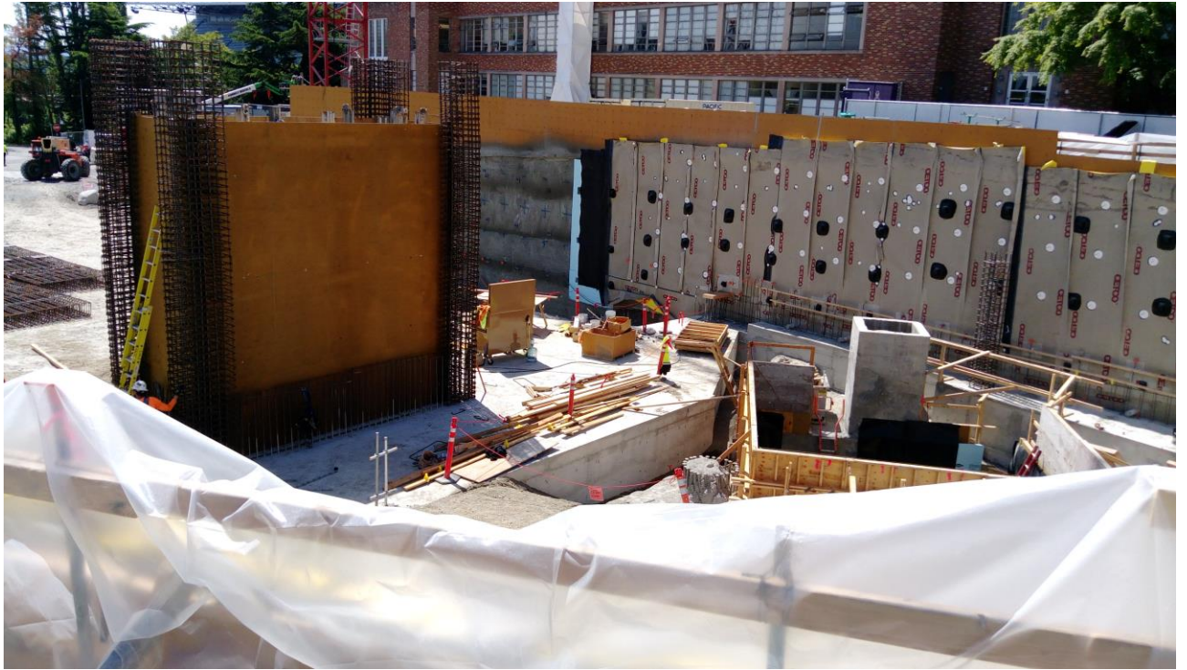
圖 8 為防止土石崩塌，開挖工程四周施作擋土牆
