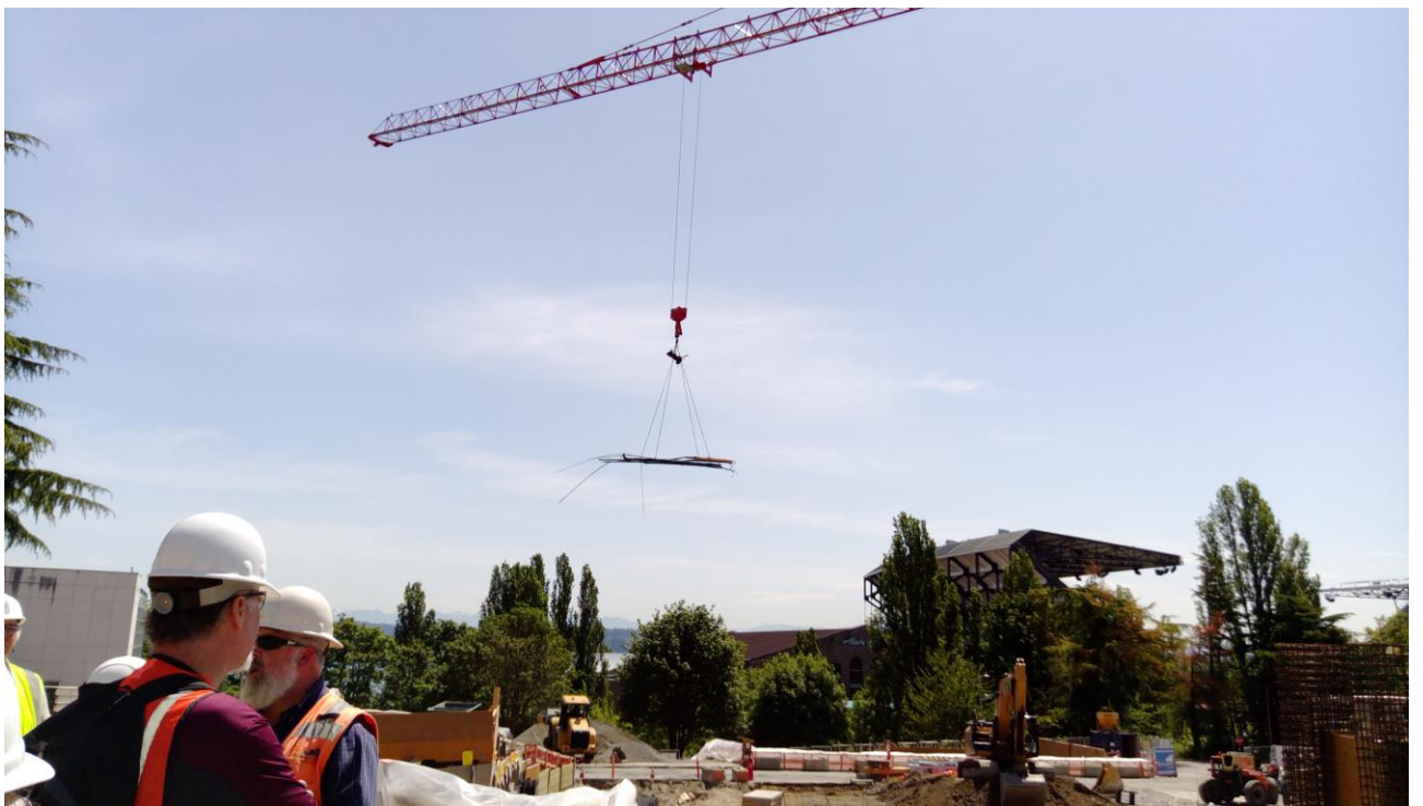
圖 7 人字臂起重桿吊掛物體移動時發出警告聲響，避免物體飛落擊傷下方工作人員
