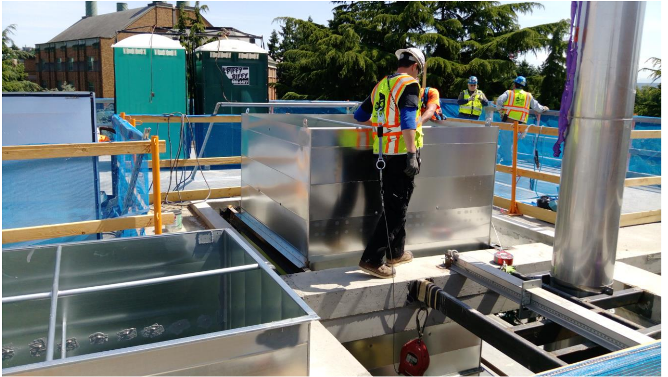
圖 6 人員正在組裝通風排氣設備時附近開口，勞工配戴防墜落安全帶，以避免人員墜落
