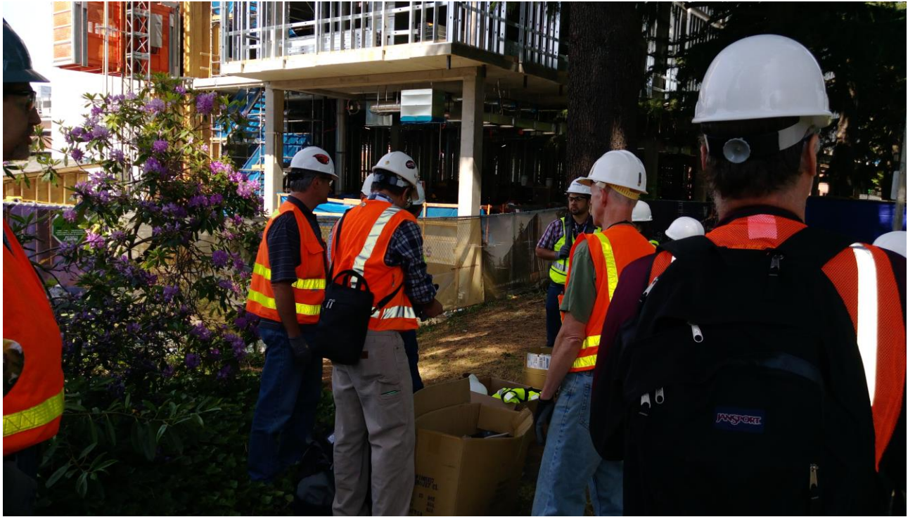
圖 2 美國華盛頓州立大學西雅圖校區生物科學大樓新建工地現場
