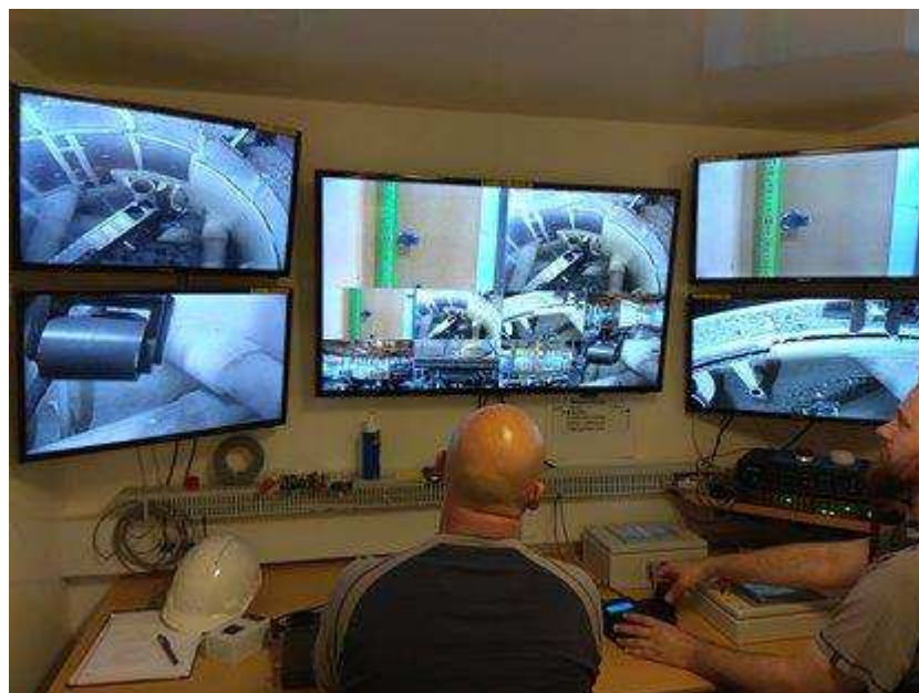
圖六、DR-3 爐內鉛襯切割操作控制室
