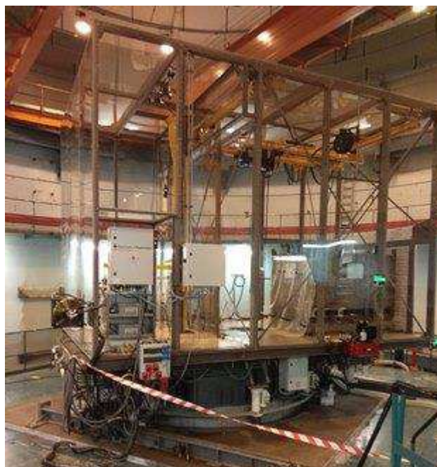
圖七、DR-3 爐內切割作業與監視系統工作站
