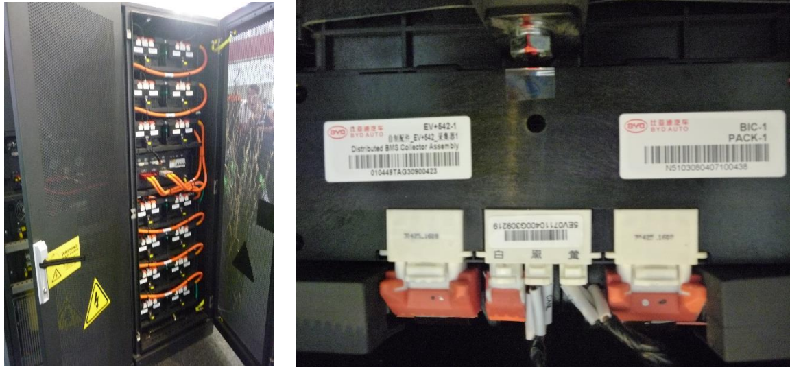
圖 32、Fenecon 儲能系統櫃(左)與採用比亞迪電動車用電池(右)。
