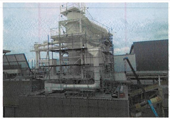
集塵設備(設備因近海，維修成本極高，參觀當日，該設備維修中，但生產線未停工)
