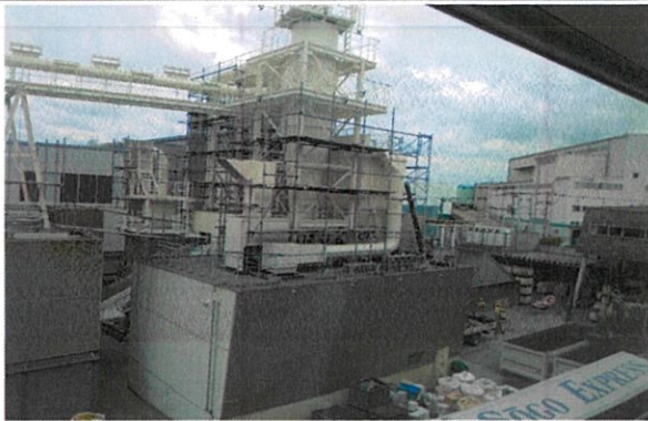
集塵設備(設備因近海，維修成本極高，參觀當日，該設備維修中，但生產線未停工)
