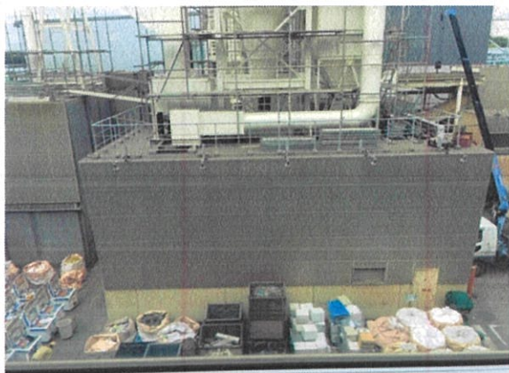
廢小家電處理區及處理後物料貯存區
