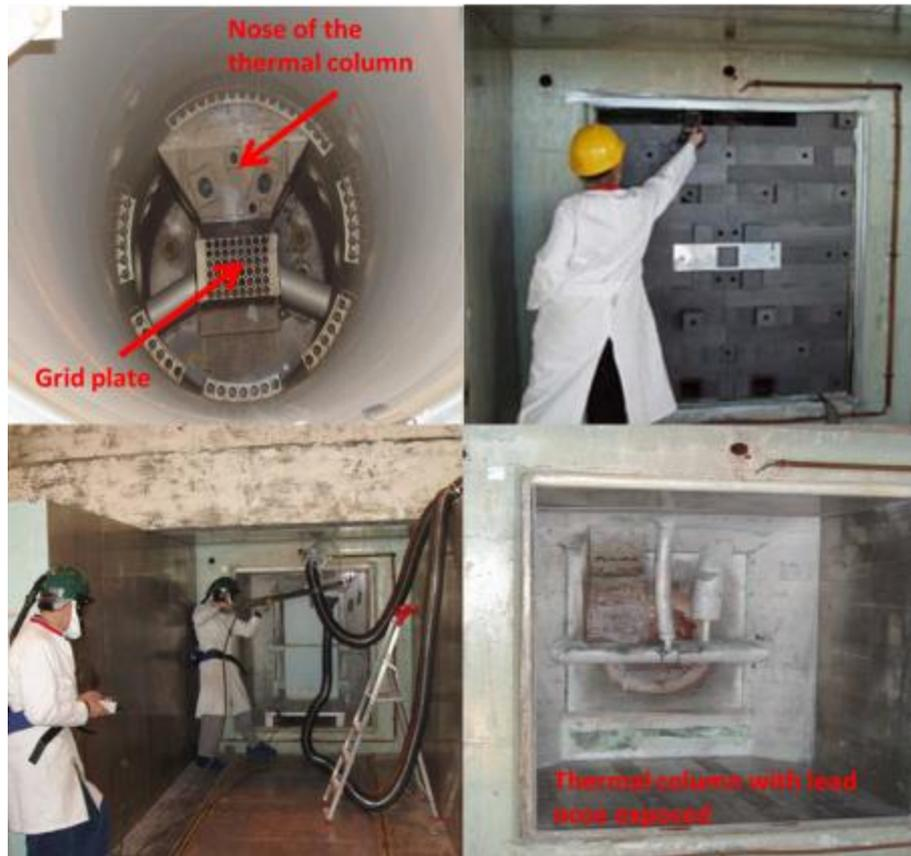
圖 十四、DR 2 熱柱與柵格板拆除過程
