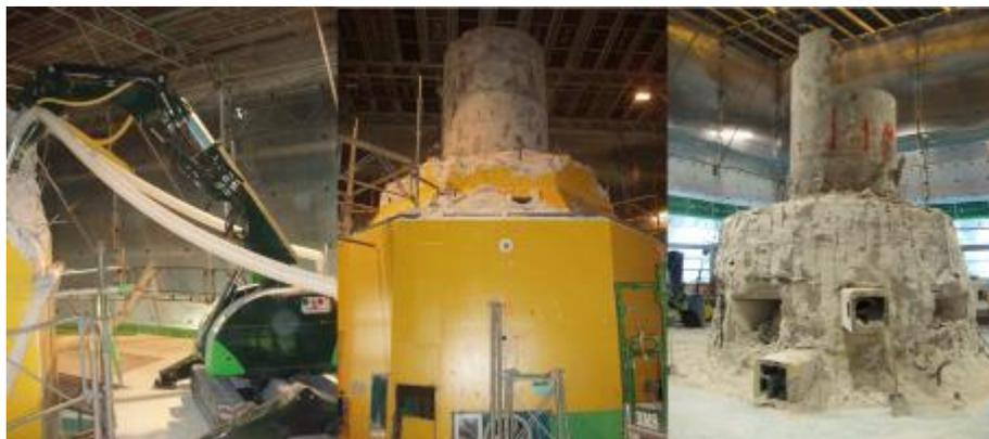
圖 十五、DR 2 反應器主結構拆除
