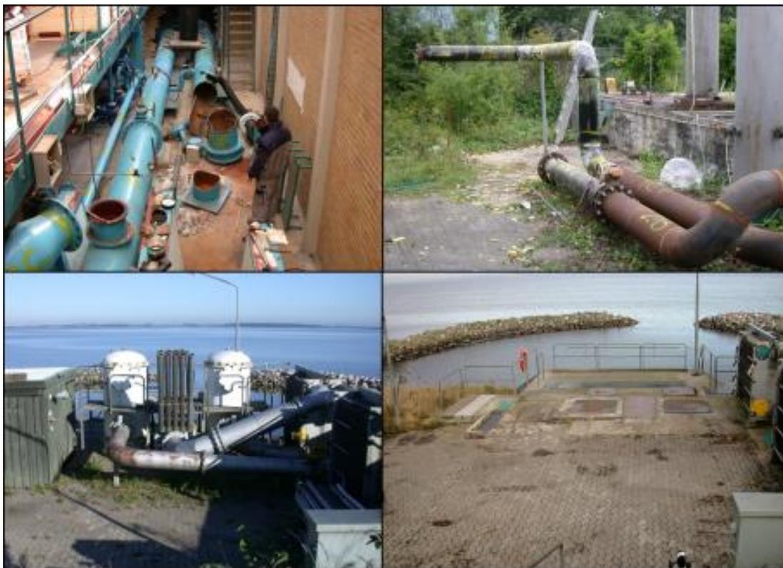
圖 十七、DR 3 外部冷卻系統拆除
