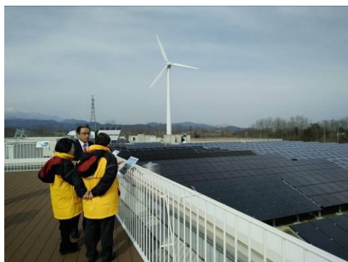
風力發電與太陽能發電測試場域
