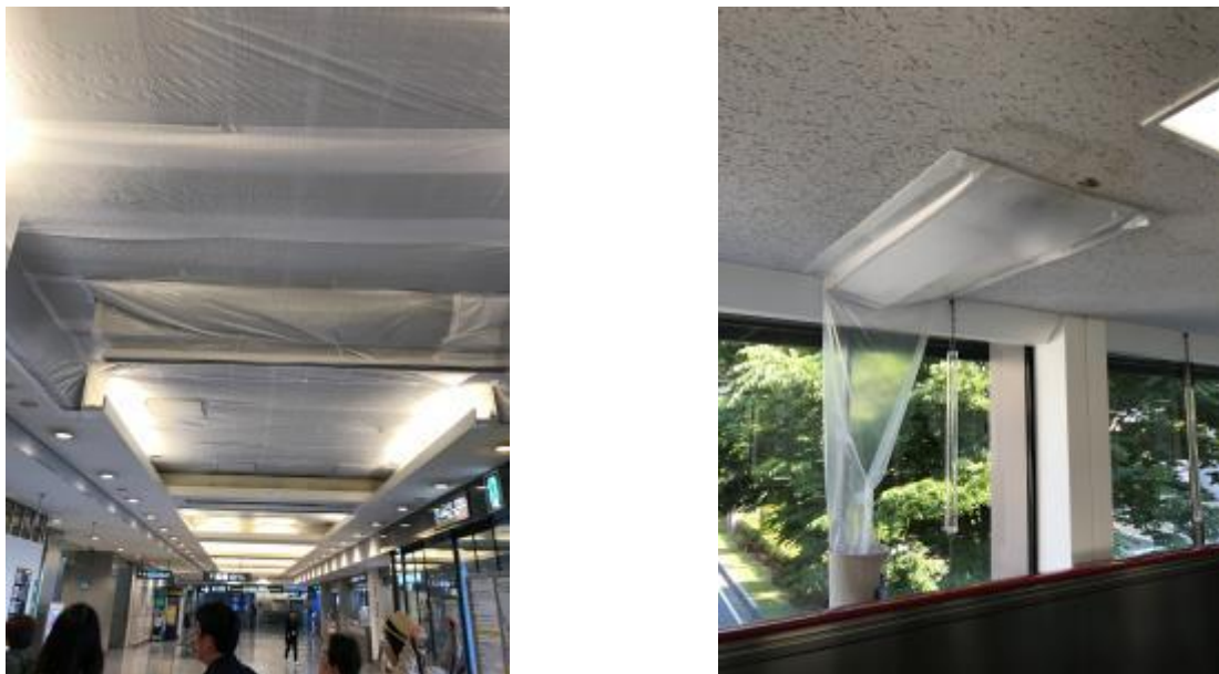
圖4.3.9 成田機場施工中防護措施
