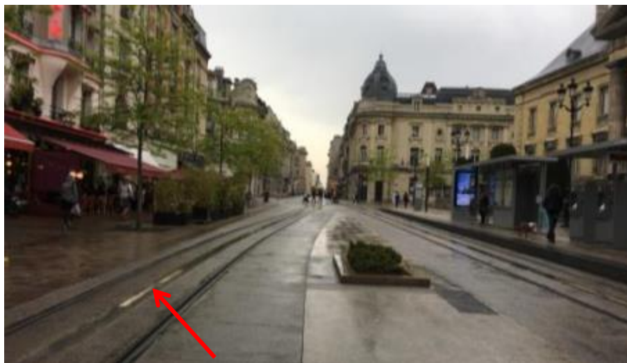
圖 3.3. 5 法國 Reims 採用 Alstom 第三軌供電系統 APS
