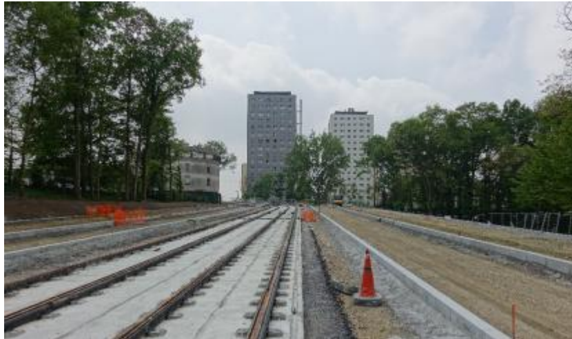
圖 3.6. 2 T4 延伸線施工現況
