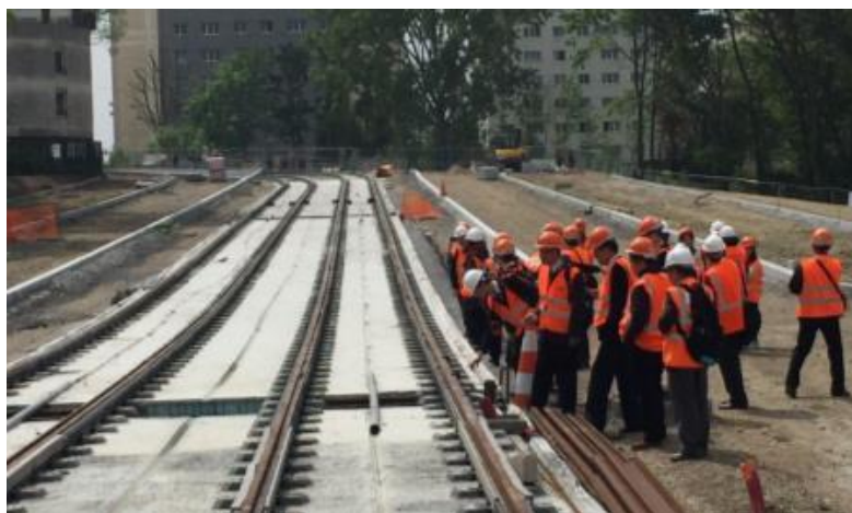
圖 2.3 法國 T4 Tram-Train 工地參訪
