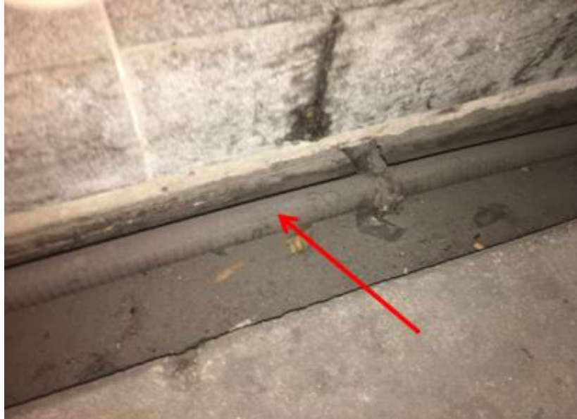
圖 3.3.15 西班牙 LUCEROS ATP EUROLOOP 安裝於月臺邊緣下方
