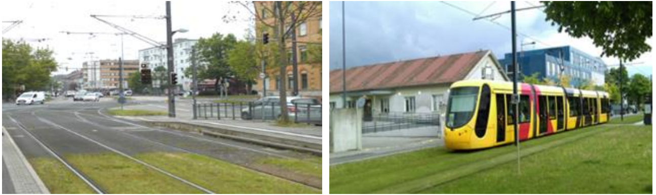
圖 3.4.2 路面上輕軌運用較高之道碴或草坪阻隔其他車輛
