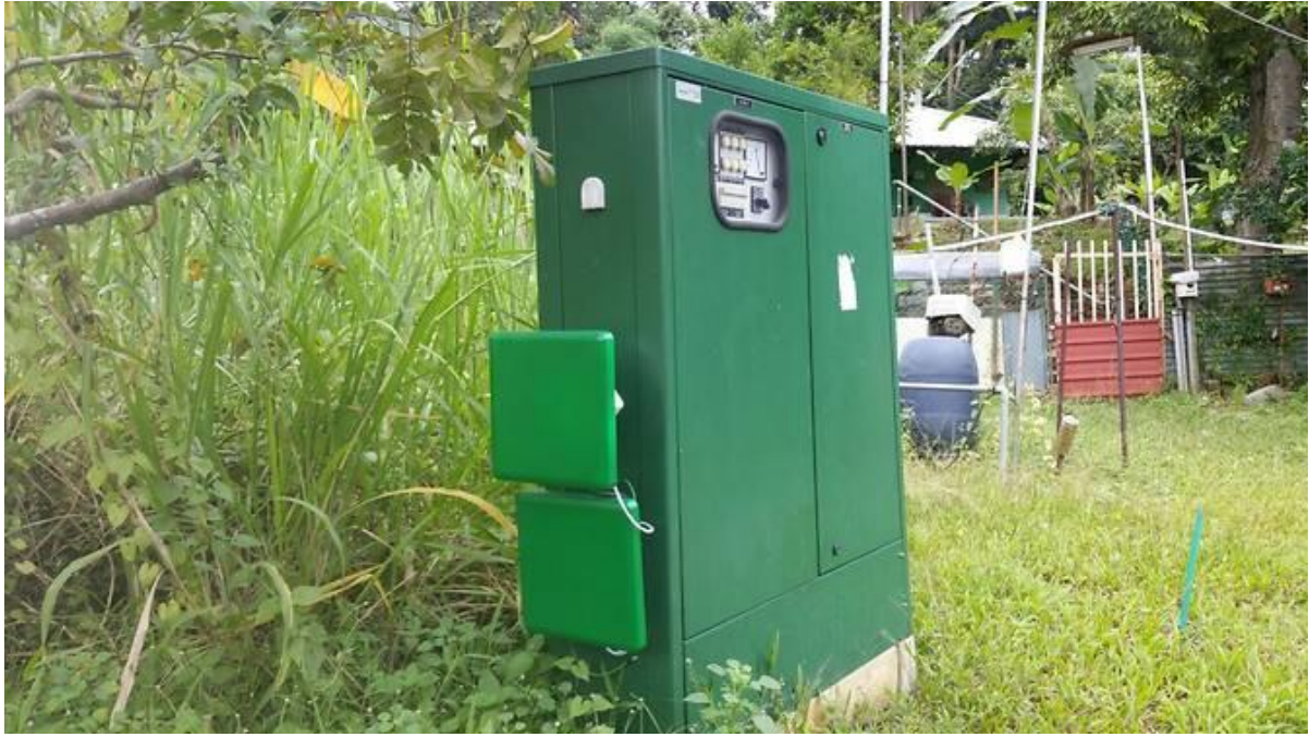
圖12、屋外配電盤旁的綠色方形天線
