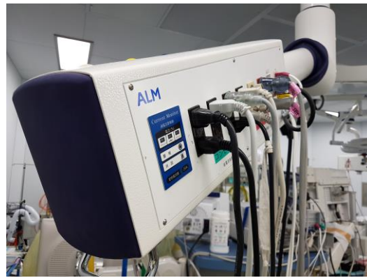
圖十四 內視鏡連線整合於吊柱上
