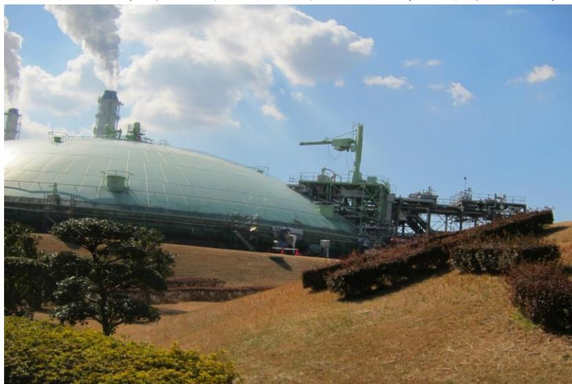
圖三、袖之浦地下式 LNG 儲槽
