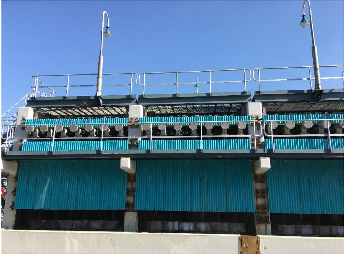
圖四、袖之浦接收站使用開架式汽化方式(ORV)
