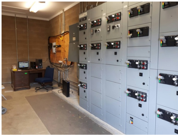
槽體內水質透過電子儀器監測
