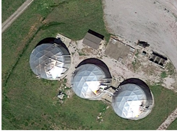
廢水儲存槽空照圖
