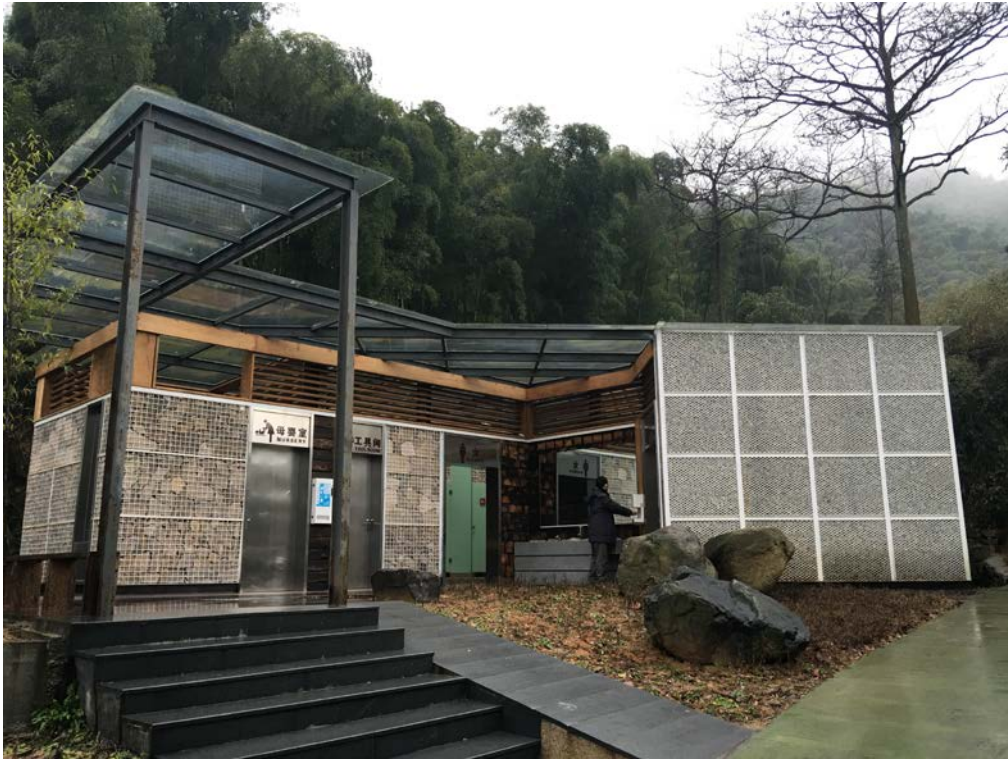
圖 33 高家堂旁簡約廁所
