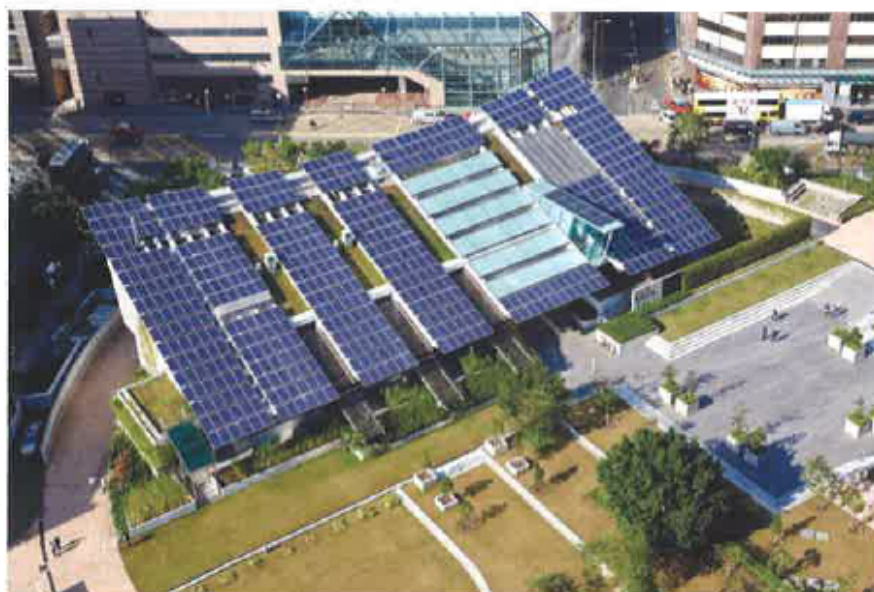
圖12 零碳天地的太陽能板
