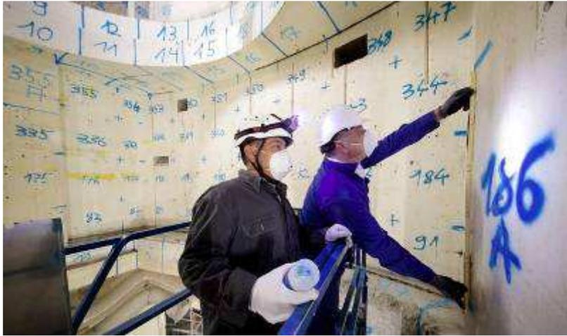
圖 23 KTE 多目的研究反應器除役作業
