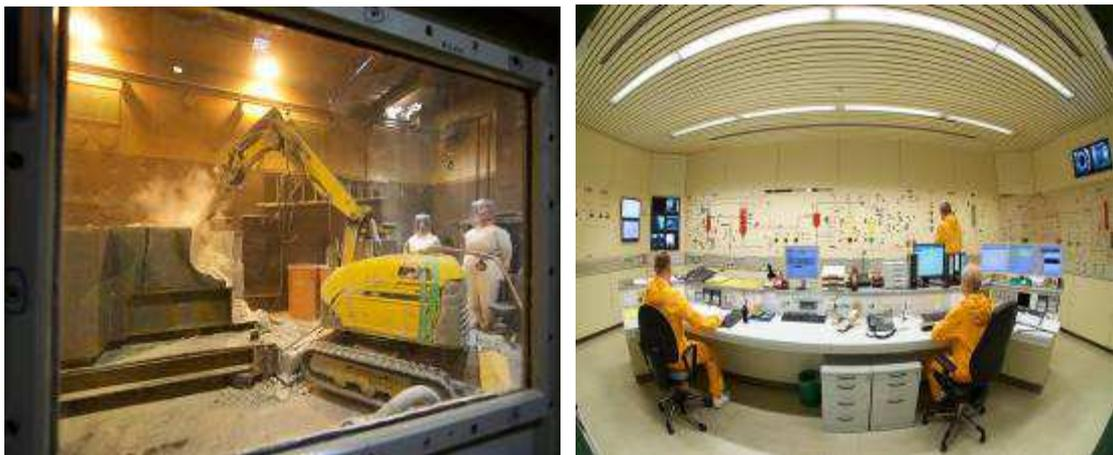
圖 21 含有低放射性之混凝土壓碎作業、低放射性可燃廢棄物之焚化控制室
