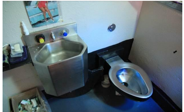
圖 15:收容人衛浴設備
