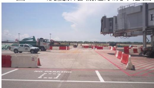
圖 64. 施工中的機坪以圍籬隔絕
