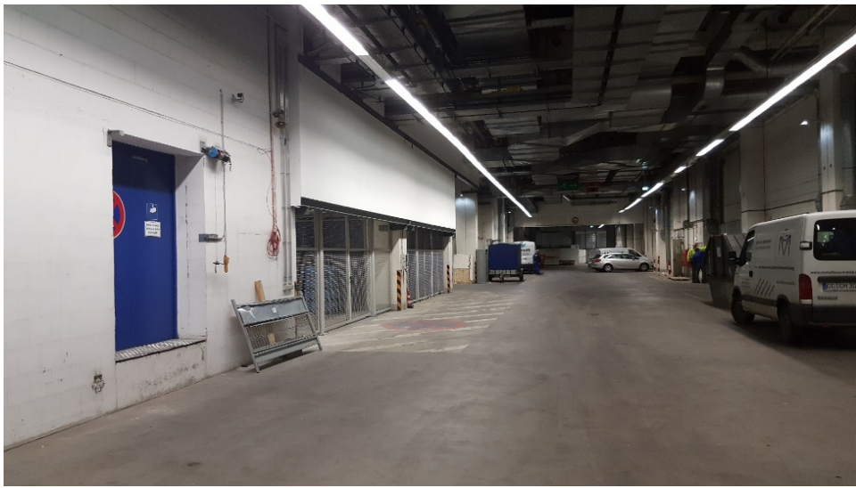
圖7.31 法蘭克福國際機場辦公大樓地下室
