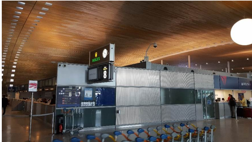
圖7.43 戴高樂國際機場CCTV直接架設於設備上
