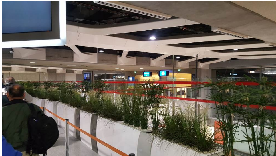
圖 7.1 戴高樂國際機場第一航廈，特殊造形之空調風管與室內天花融為一體
