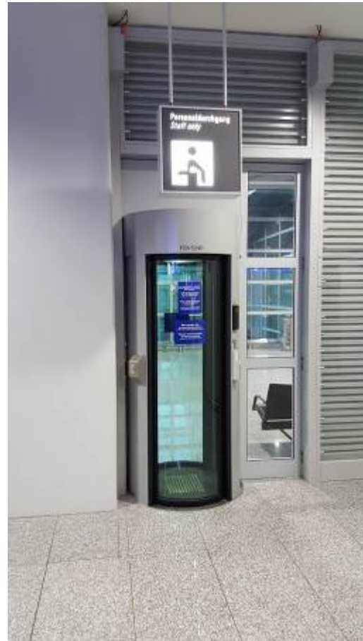
圖5.6 員工專用自動安檢門
