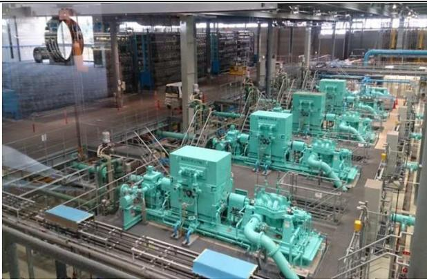
圖 2.5-14 高壓 RO 泵及能源回收裝置
