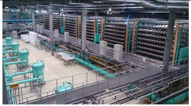
圖 2.5-13 UF 前處理系統及過濾器
