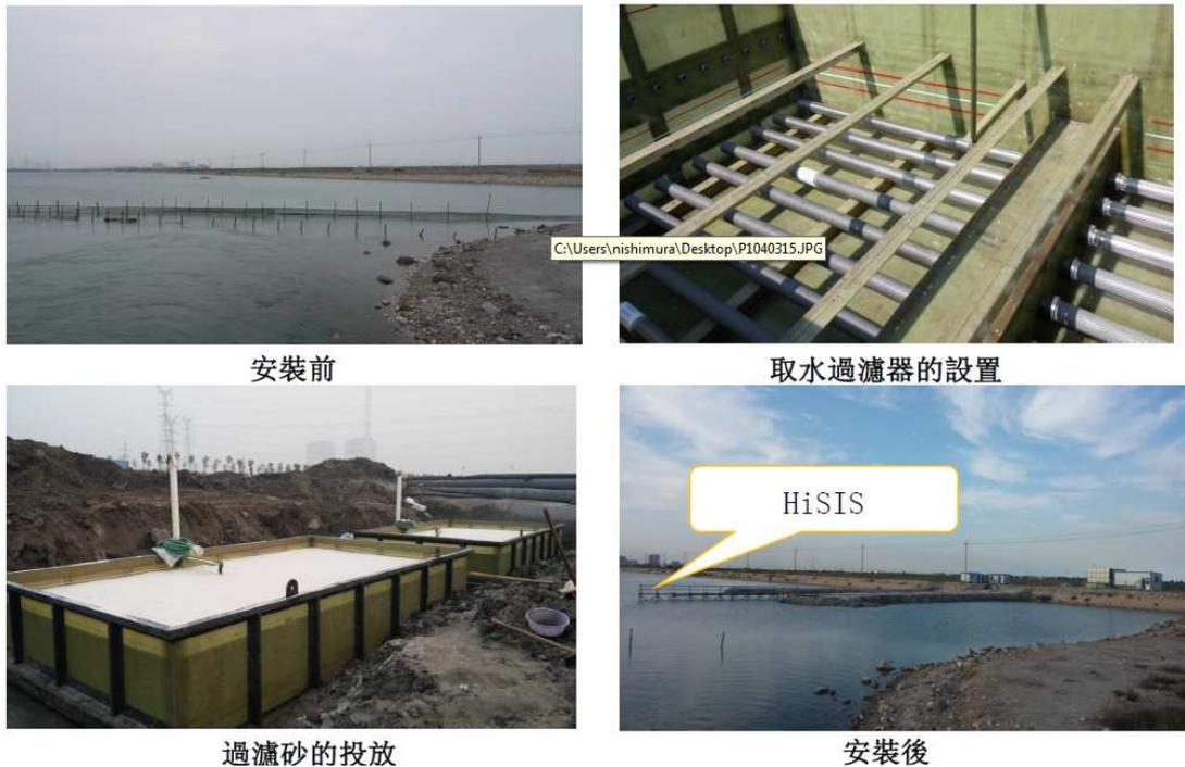
圖 2.3-20 模組化設計之 HiSIS 取水設施(多套系統可串聯)
