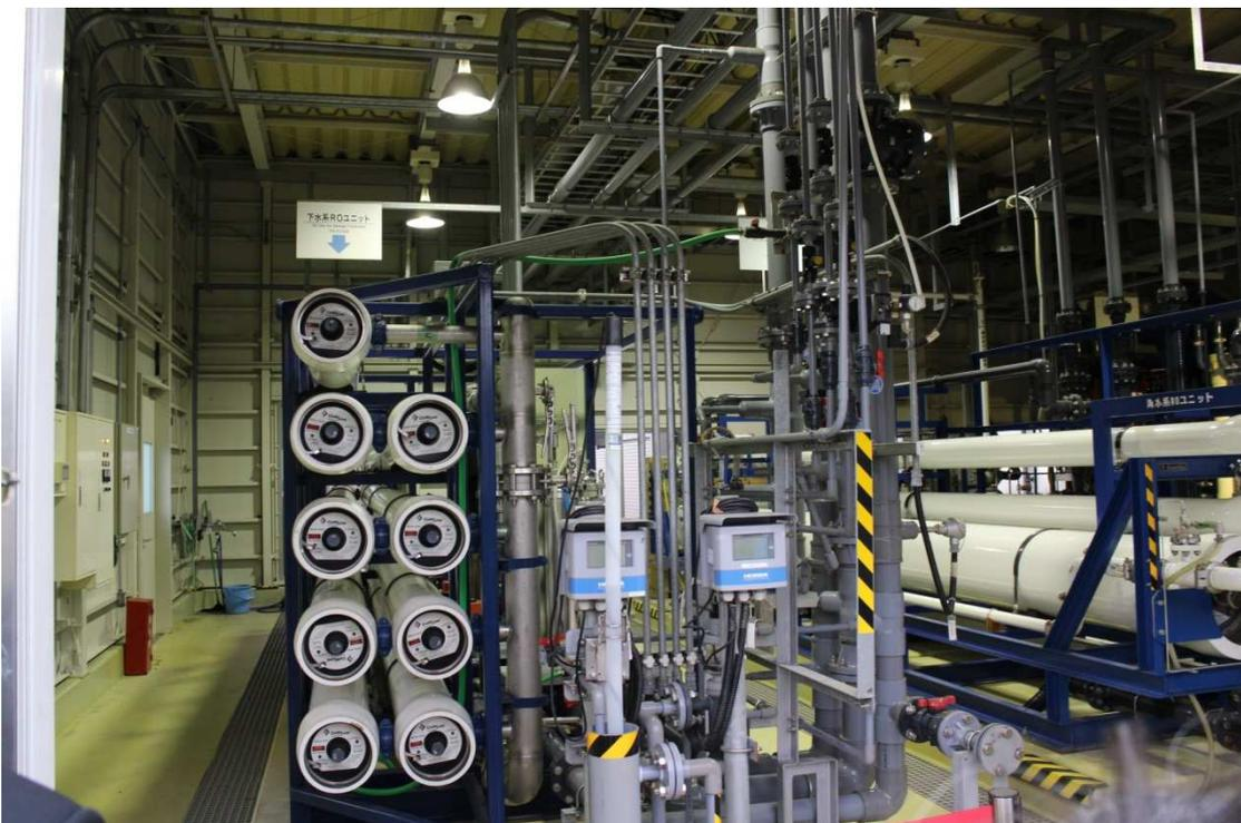
圖 2.4-18 污水處理 RO 系統
