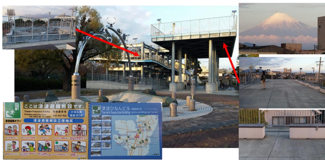
圖 9 三保交流廣場的海嘯鋼骨避難塔
