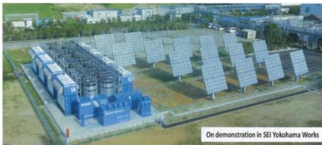
圖 4、住友電工橫濱製作所釩液流電池示範場域。
