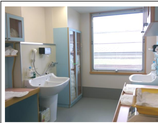
圖46.位於產後病房之嬰兒沐浴間。
