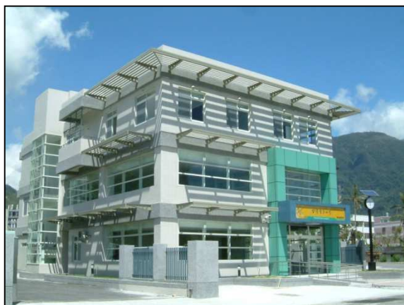
台電花蓮區處新城服務所
